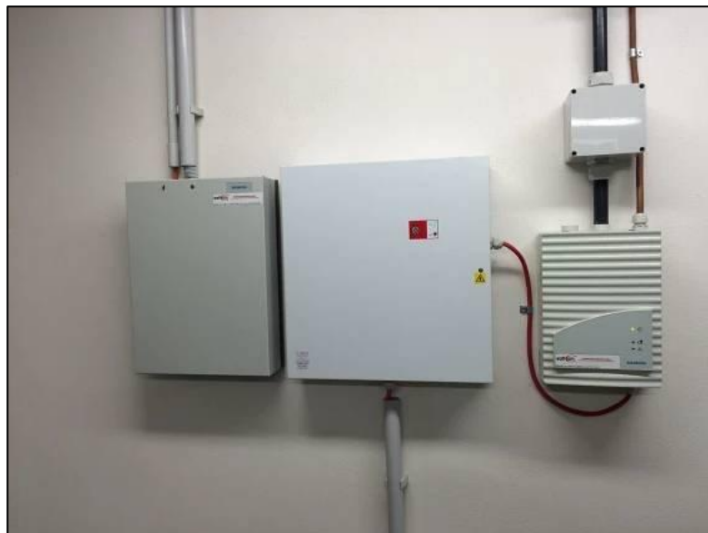
Obrázek 5: Ústředna elektrické požární signalizace 12
