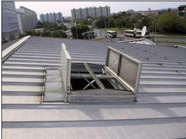
Obrázek 7: Zařízení na odvod kouře a tepla 17
