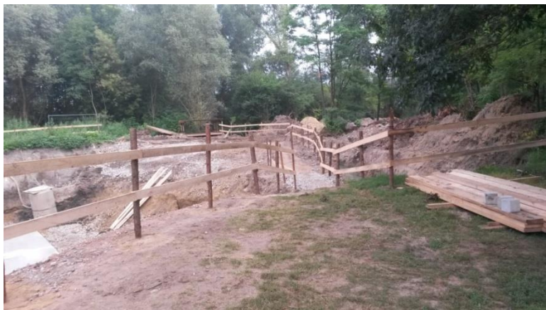
Obrázek 25 - Vnitřní zabezpečení staveniště, zdroj: vlastní
