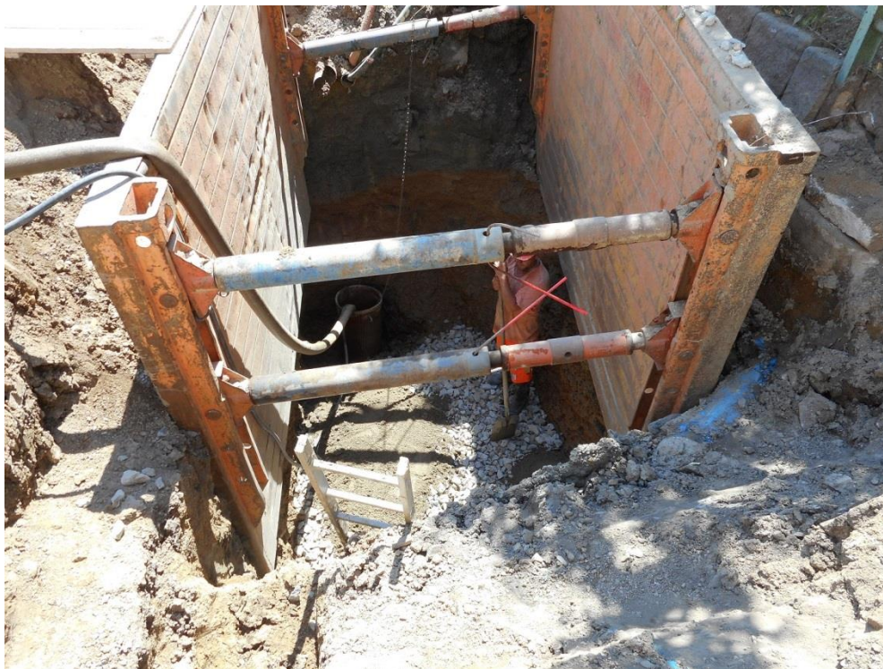
Obrázek 14 - Výstup/sestup pomocí žebříku, zdroj: vlastní
