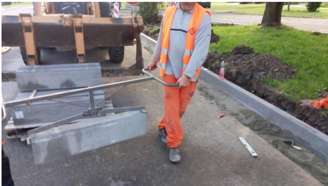
Obrázek 28 - Vhodná manipulace s obrubou, zdroj: vlastní
