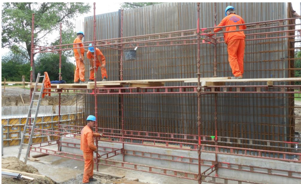
Obrázek 22 - Vázání výztuže z lešení, zdroj: vlastní
