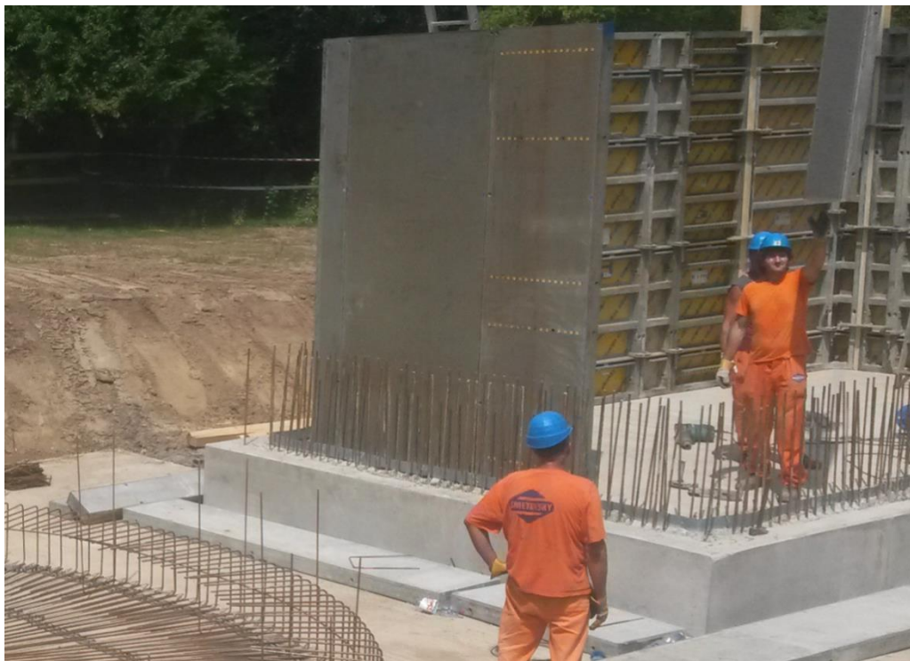
Obrázek 20 - Montáž systémového bednění, zdroj: vlastní
