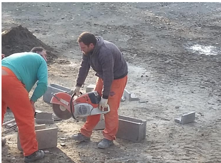
Obrázek 26 - Nesprávná práce s rozbrušovacím strojem, zdroj: vlastní
