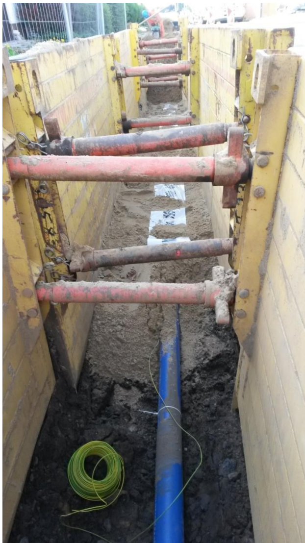
Obrázek 16 - Správně zajištěný výkop, zdroj: vlastní
