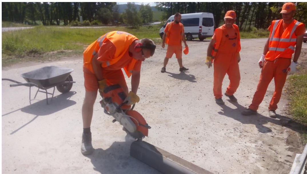
Obrázek 27 - Použití OOPP při práci s rozbrušovacím strojem, zdroj: vlastní
