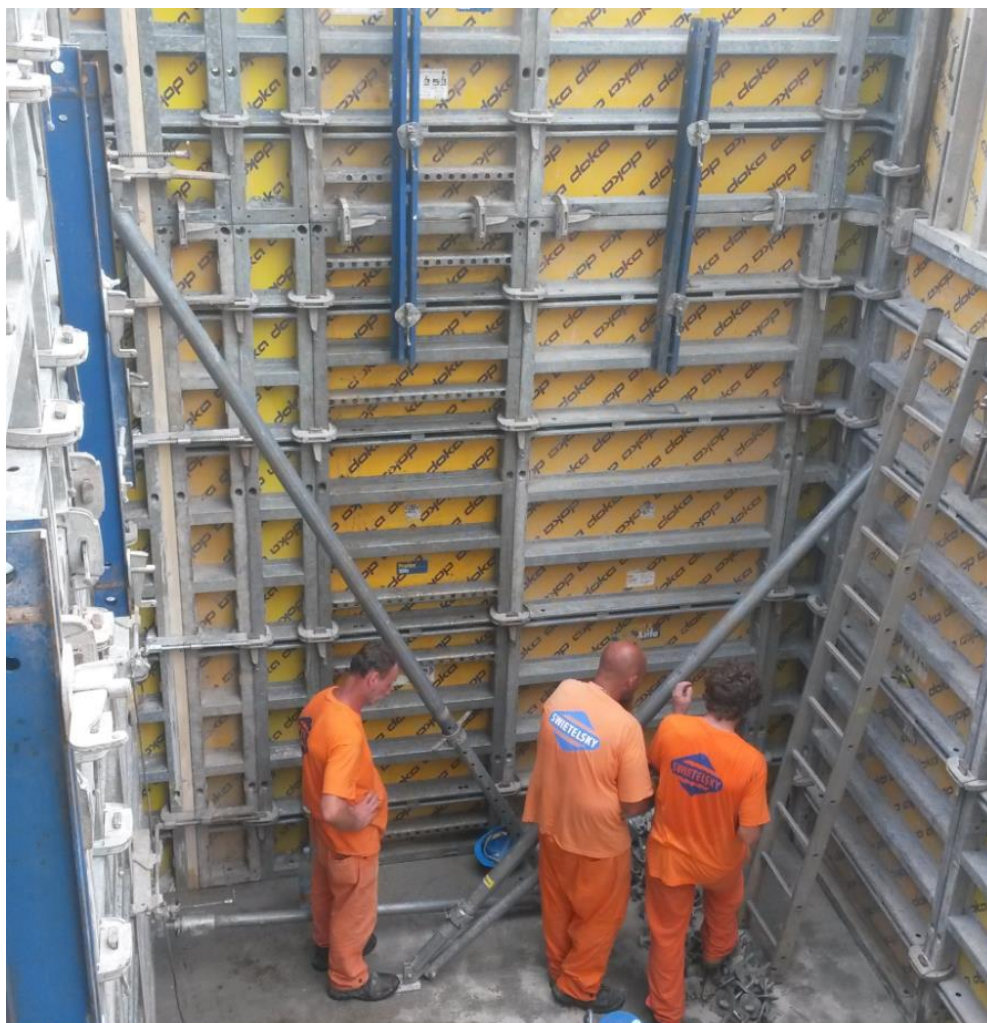
Obrázek 21 - Montáž systémového bednění, zdroj: vlastní
