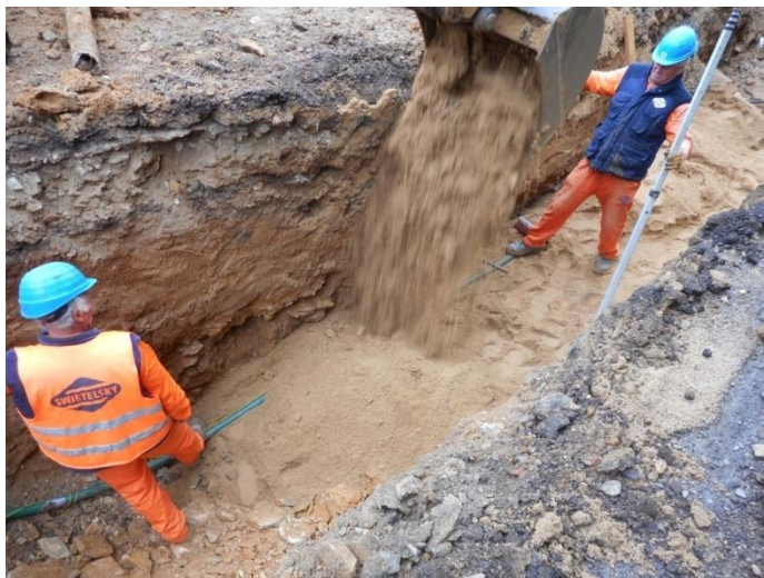
Obrázek 11 - Práce v nebezpečném prostoru stroje, zdroj: vlastní
