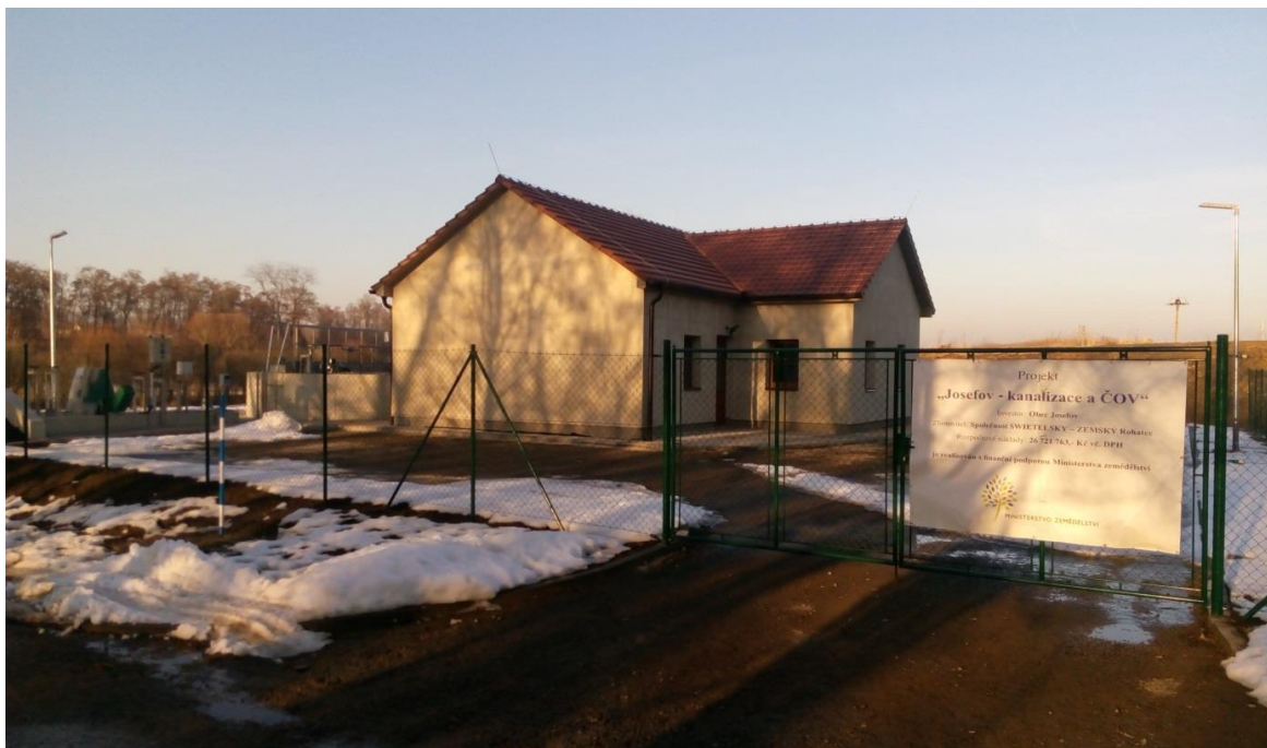
Obrázek 5 - Stavba Josefov – čistička odpadních vod, zdroj: vlastní
