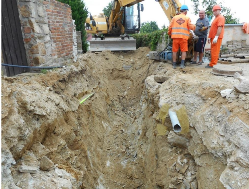
Obrázek 7 - Výkopové práce v obci, zdroj: vlastní
