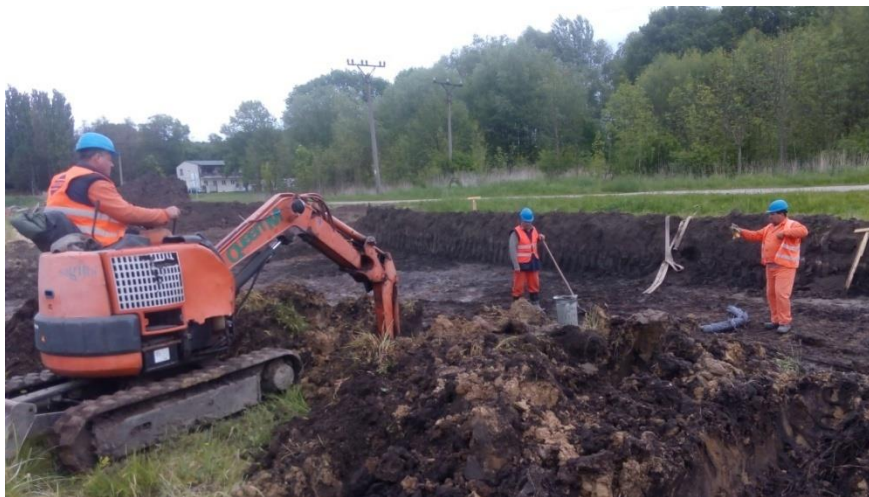
Obrázek 12 - Práce mimo nebezpečný prostor stroje, zdroj: vlastní
