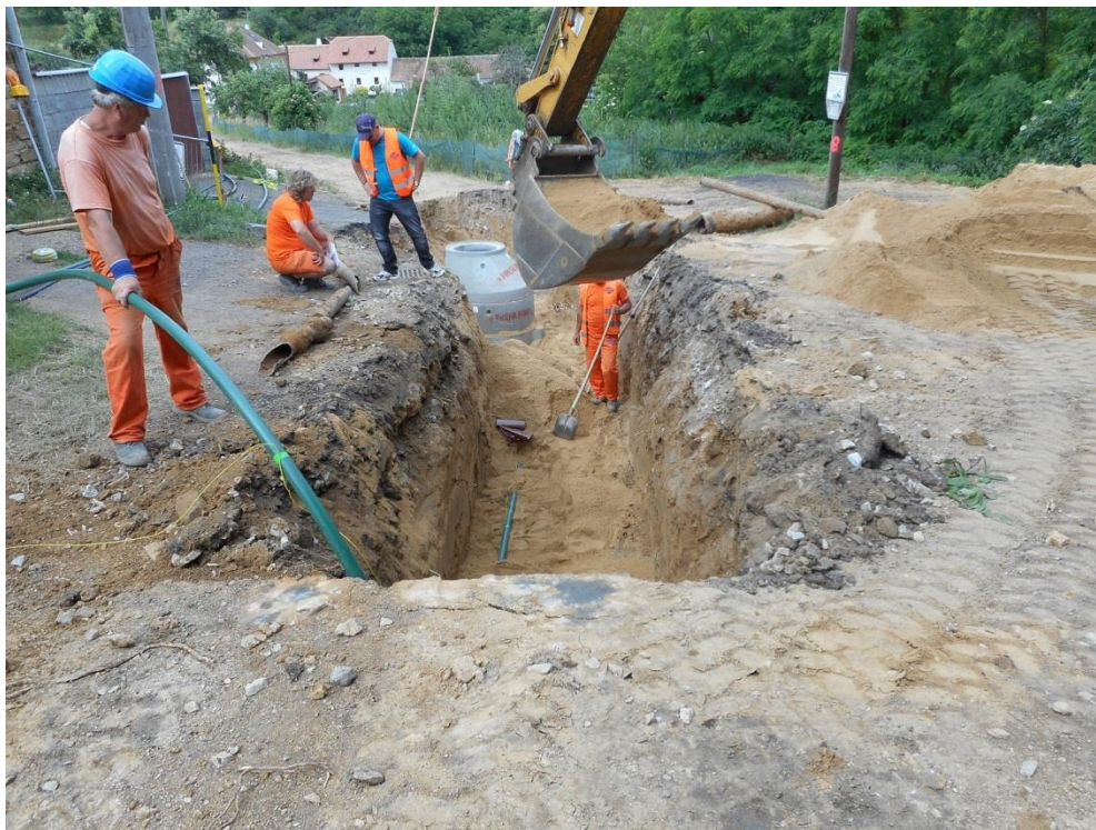
Obrázek 10 - Výkopové práce v obci, zdroj: vlastní
