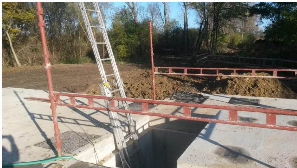
Obrázek 29 - Vstup do nádrže, zdroj: vlastní
