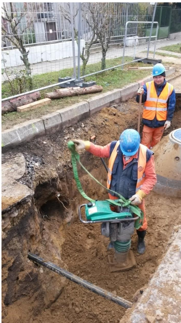
Obrázek 17 - Hutnění výkopu pomocí vibračního pěchu, zdroj: vlastní
