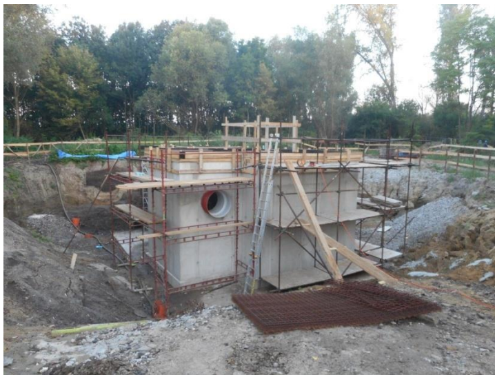
Obrázek 6 - Stavba Josefov – přečerpávací stanice, zdroj: vlastní
