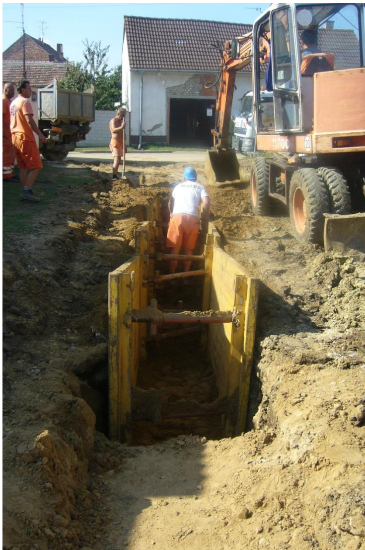
Obrázek 13 - Zajištění stěn výkop proti sesunutí, zdroj: vlastní
