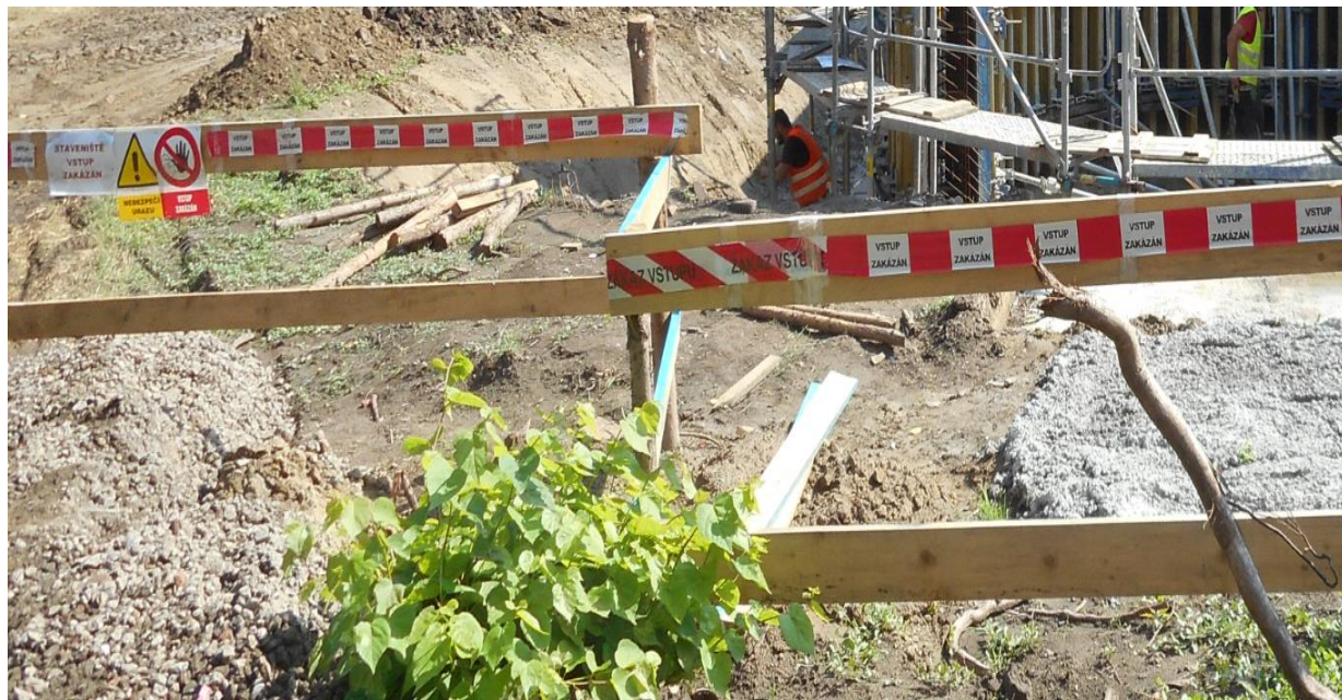
Obrázek 24 - Vnější zabezpečení staveniště, zdroj: vlastní
