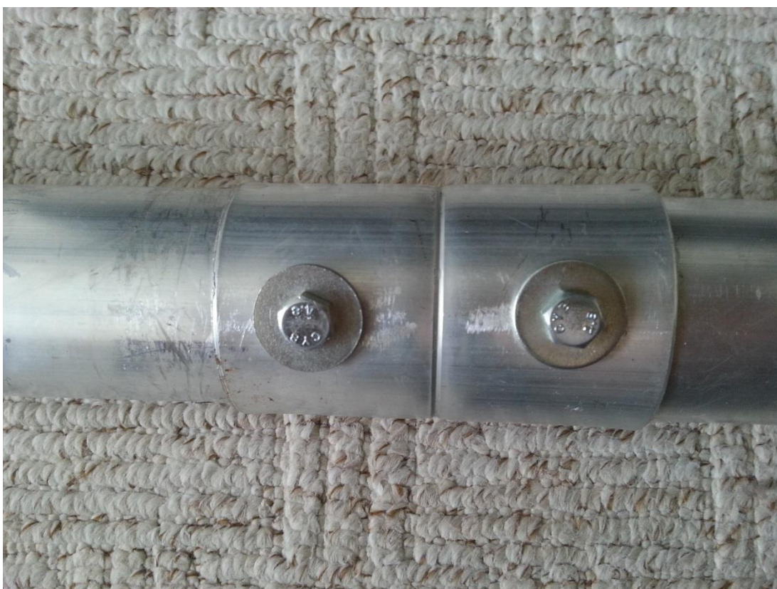
Příloha 8: Detail spojení jednotlivých dílů soutyčí (vlastní)
