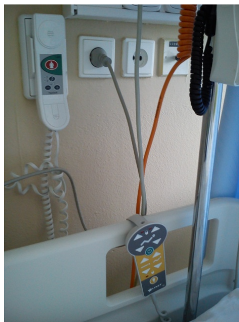
„Bílé sluchátko“ = signalizace pro pacienty k přivolání sestry. Šedo-oranžový „ovladač“ = ovládání k polohování lůžka např. pod hlavou
