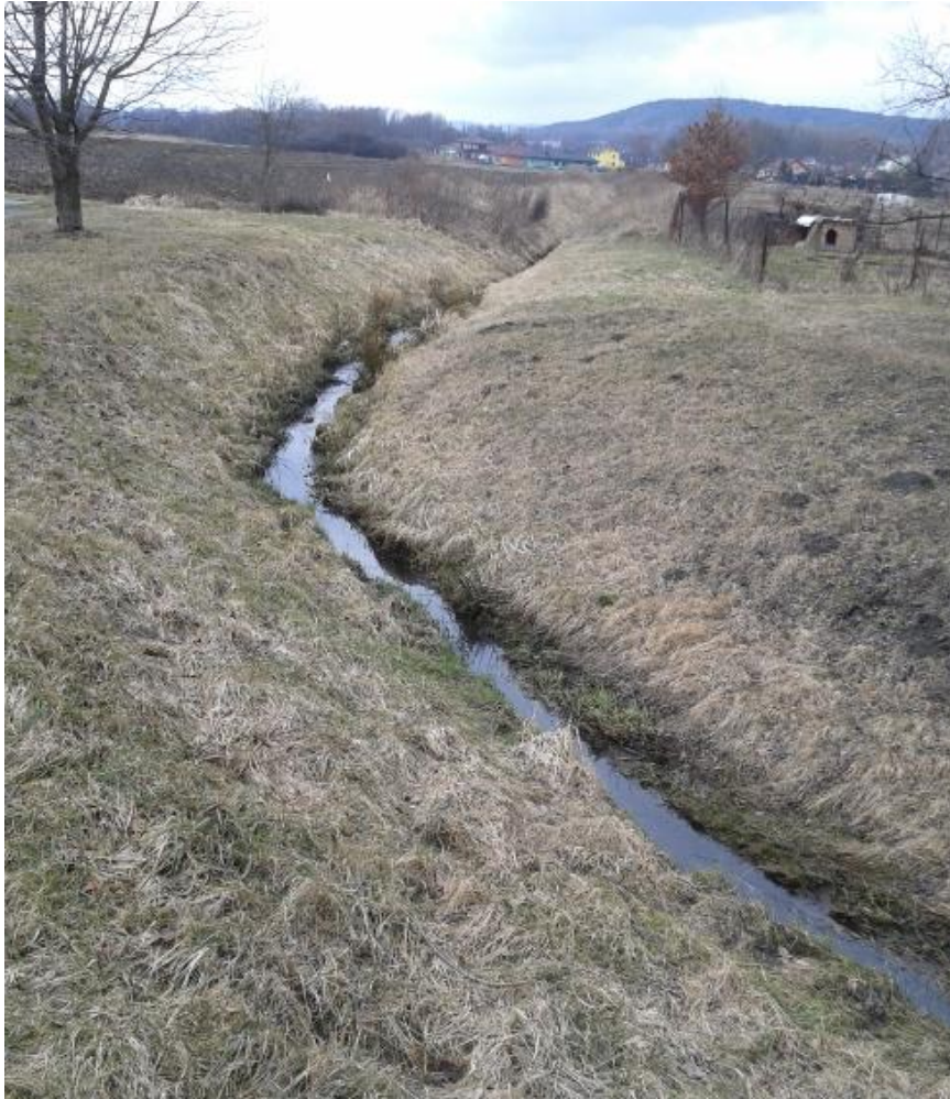
Obr. č. 10 Revitalizace potoka v obci Otovice (vyčištění)
