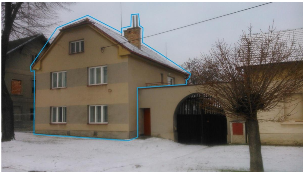
Obrázek 9 - Obytný objekt, pohled z návsi [vlastní]
