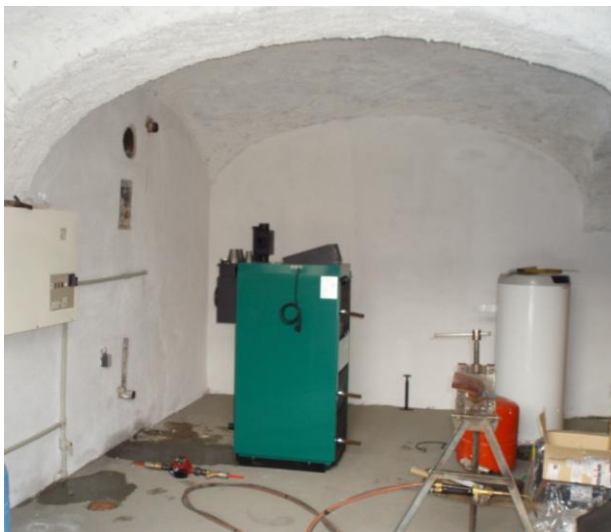
Obrázek 24 - Kotelna při rekonstrukci [vlastní]
