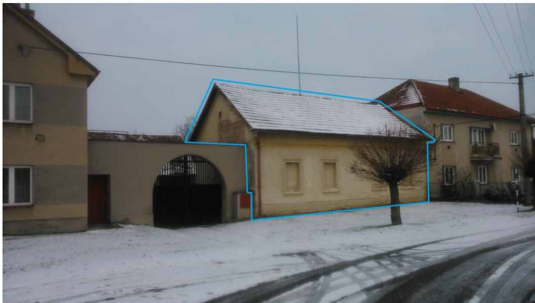
Obrázek 26 - Budova dílny, pohled z návsi [vlastní]
