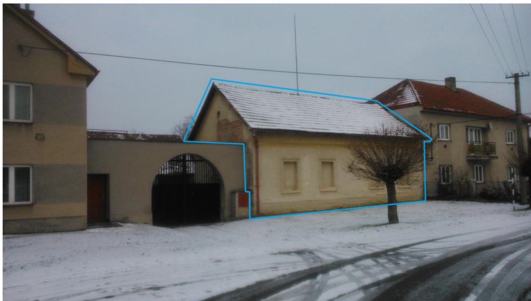
Obrázek 26 - Budova dílny, pohled z návsi [vlastní]
