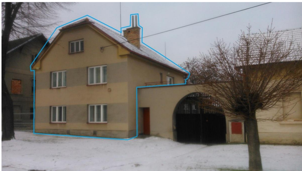
Obrázek 9 - Obytný objekt, pohled z návsi [vlastní]
