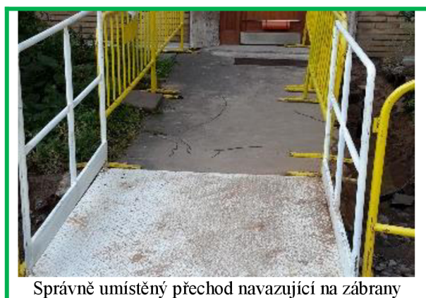
Obr. 1 – Dobrá a špatná praxe zajištění přechodu přes výkop
