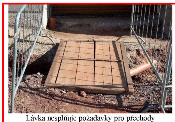
Obr. 1 – Dobrá a špatná praxe zajištění přechodu přes výkop
