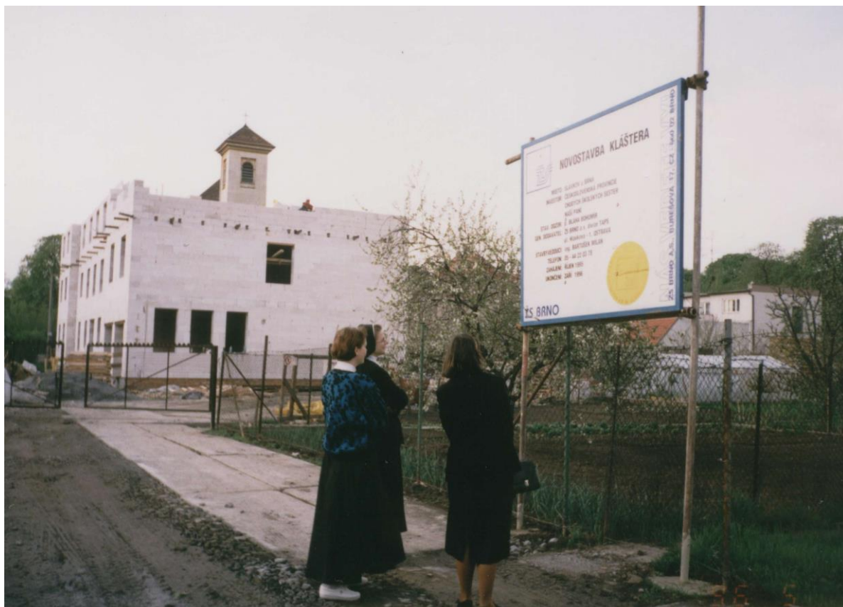
Obr. 3: Výstavba nového kláštera
