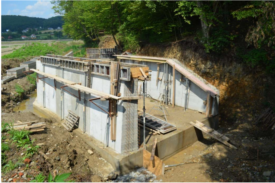
Výstavba nového bezpečnostního přepadu
