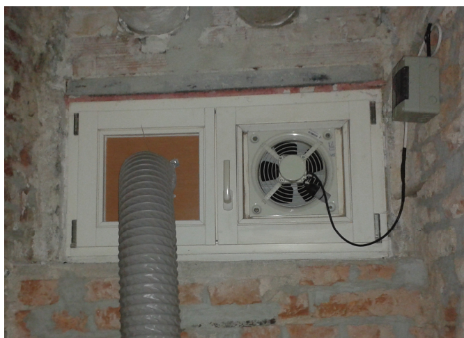
Obrázek 46 Přívod vzduchu z anglického dvorku
