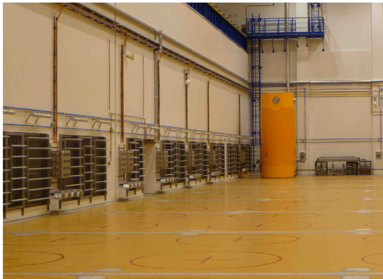
Obrázek 18 První temelínský mezisklad zaplněný jedním kontejnerem CASTOR®1000/19 [22]
