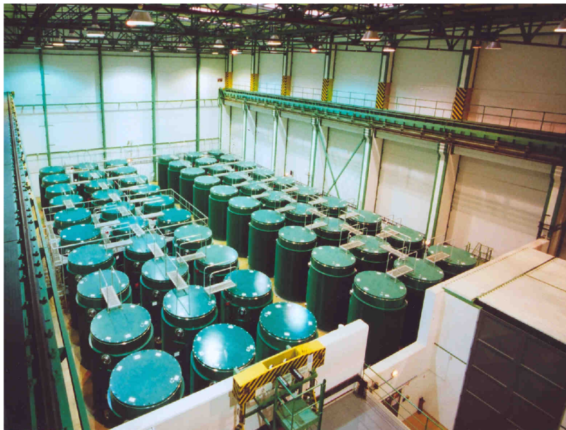
Obrázek 14 První dukovanský mezisklad - již zaplněný kontejnery CASTOR®440/84 [15]
