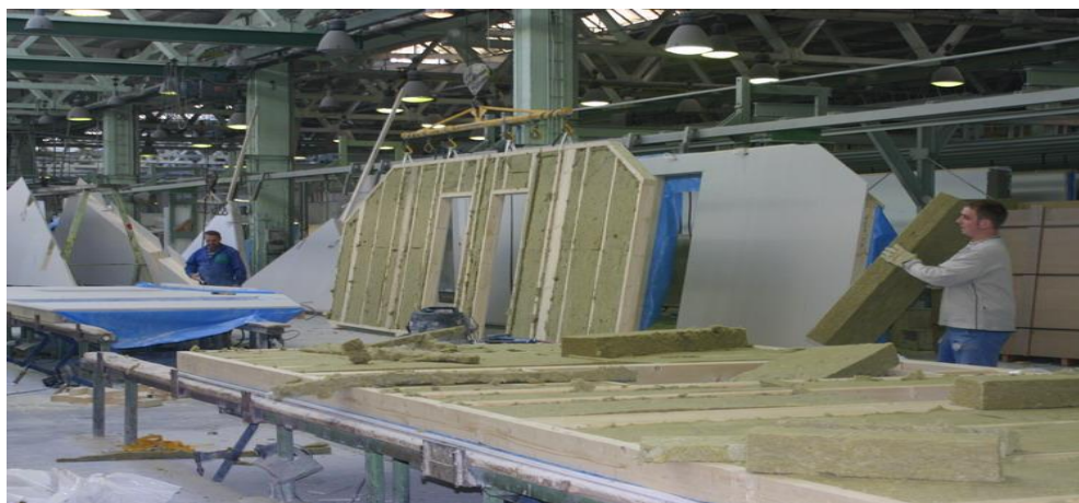
Obrázek č. 9: Výroba stěny panelové konstrukce ve firmě RD Rýmařov ( www.ceskestavby.cz , 2017-03-11).
