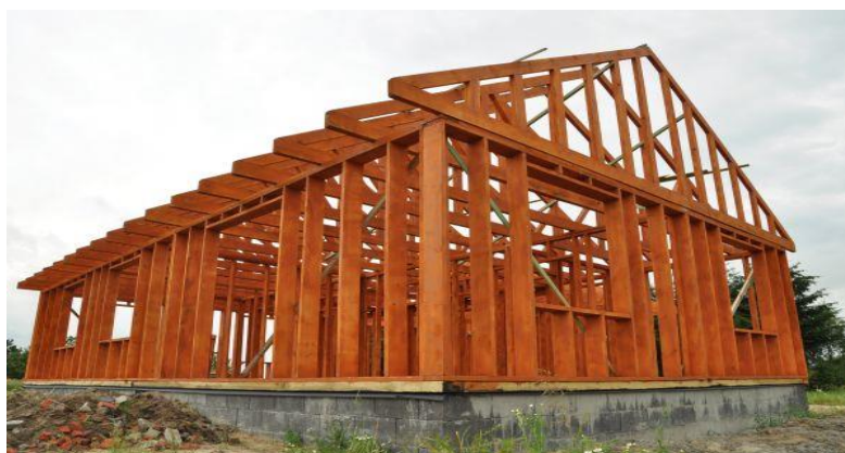
Obrázek č. 8: Rámová konstrukce jednopodlažního rodinného domu ( www.ceskestavby.cz , 2017-03-11).
