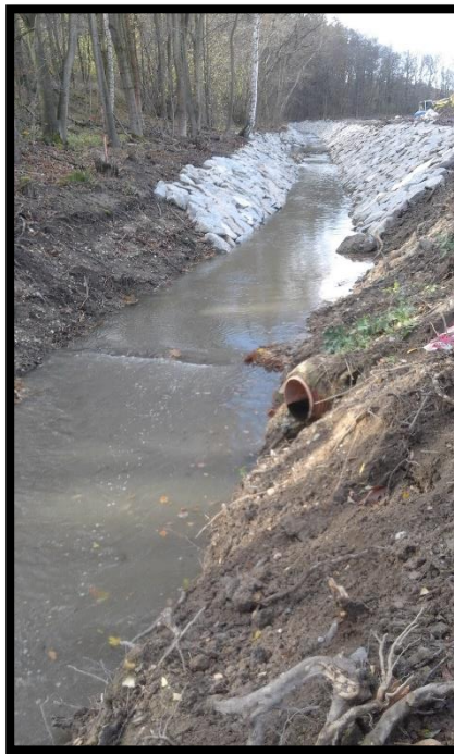
Obr. č. 35: Obnova koryta Únětického potoka (foto vlastní, 29.10.2017)
