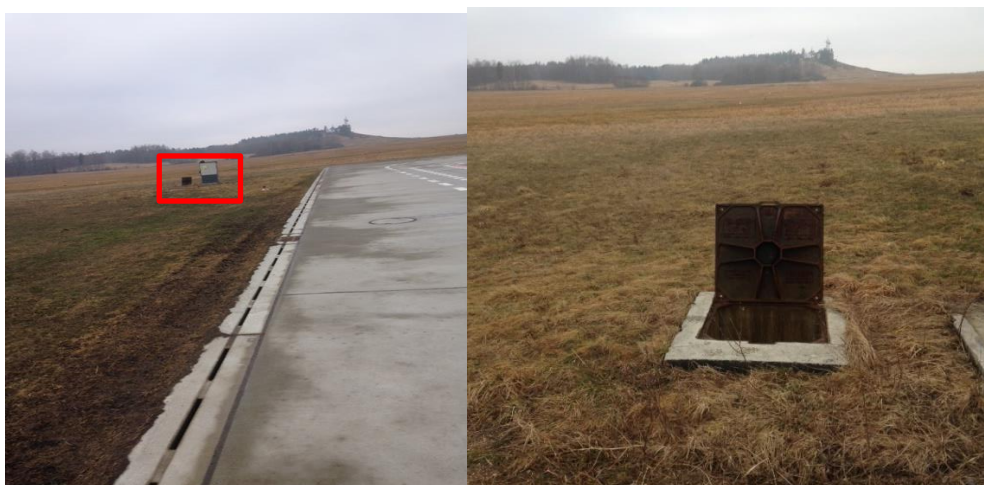
Obr. 26: AP - retenční nádrž (Sýkorová, 2017)
