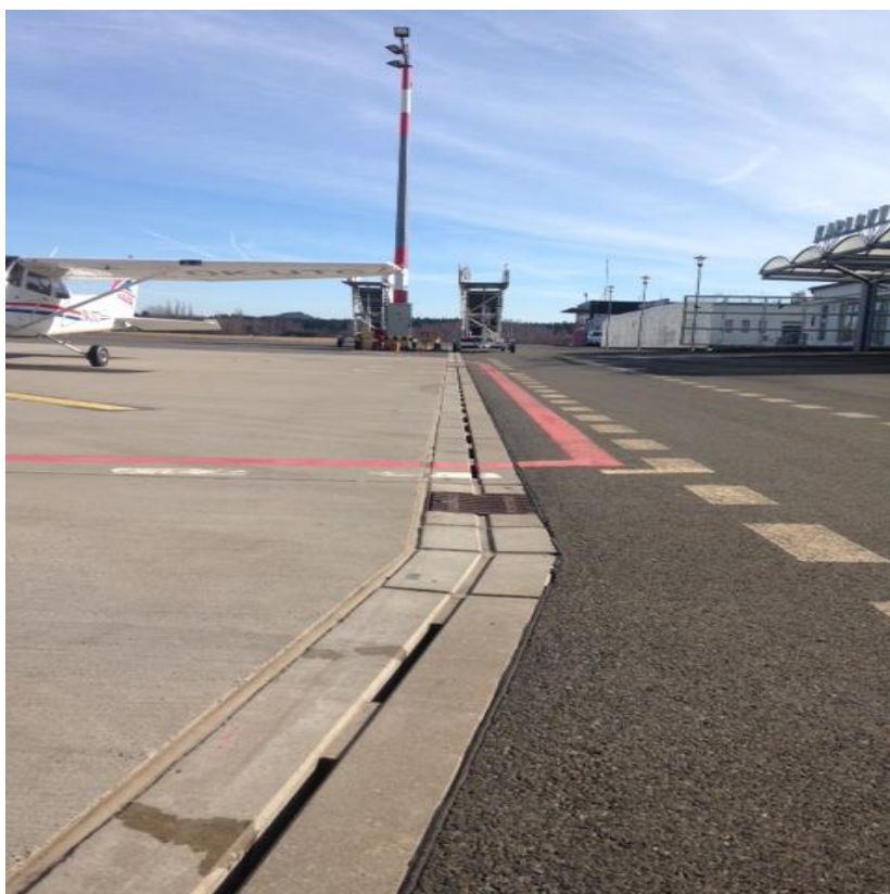
Obr. 8: Odvodňovací štěrbinové žlaby (Sýkorová, 2018)
