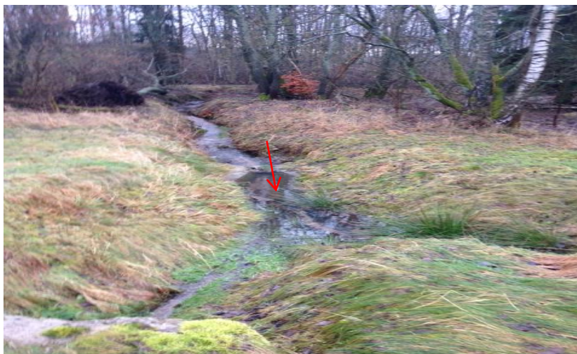
Obr. 17: KV1 - Výpusť Cínový potok (Sýkorová, 2017)
