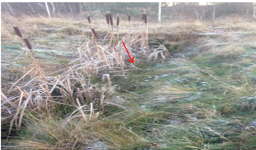
Obr. 18: KV2 -Drenáž – Cínový potok (Sýkorová, 2017)
