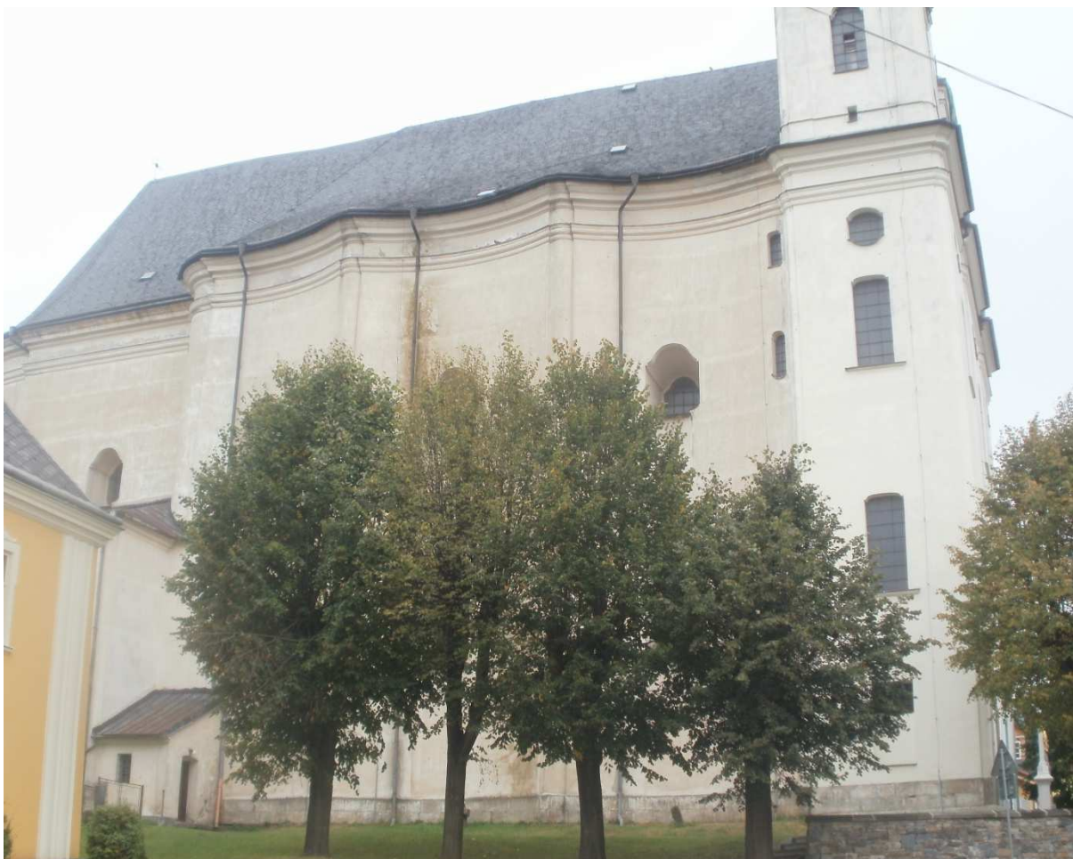
2) Pohled na boční jižní část kostela Nanebevzetí Panny Marie s vchodem do sakristie
