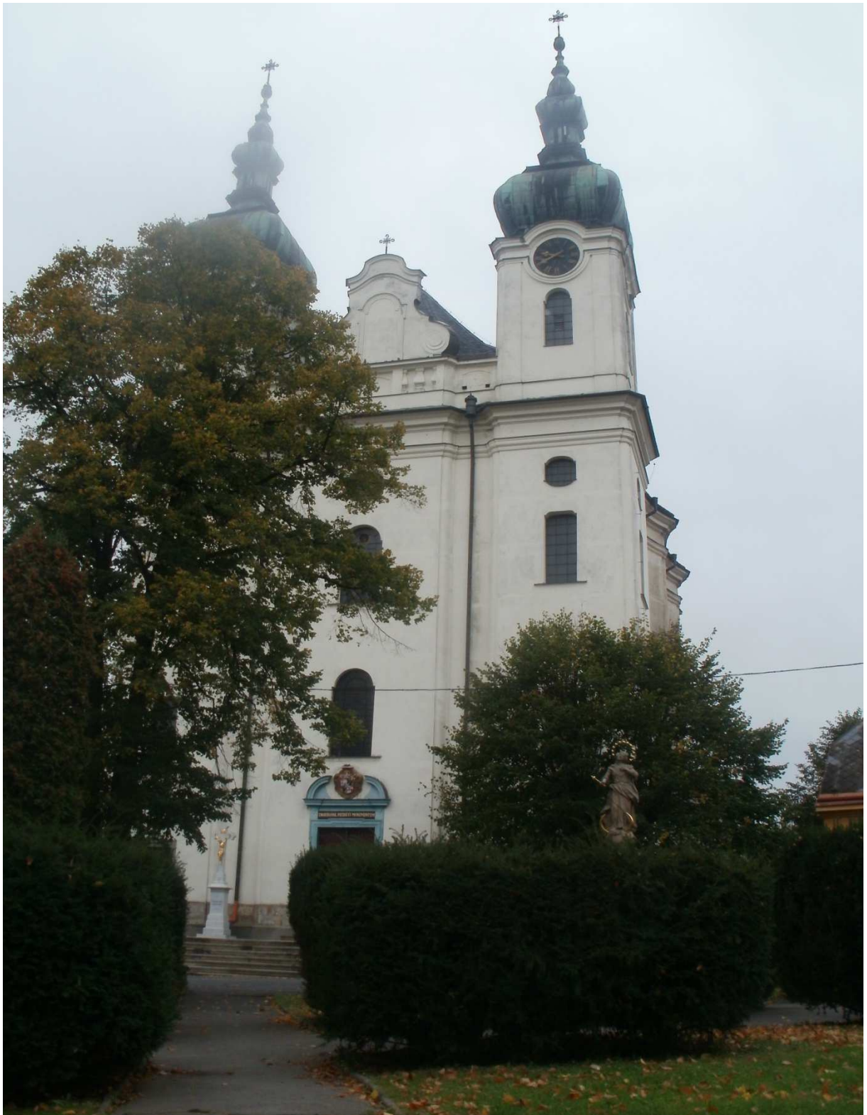
1) Pohled na hlavní dvojevěžové průčelí kostela Nanebevzetí Panny Marie v Budišově nad Budišovkou
