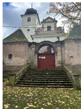
Obrázek 17: Vstup s márnicemi
