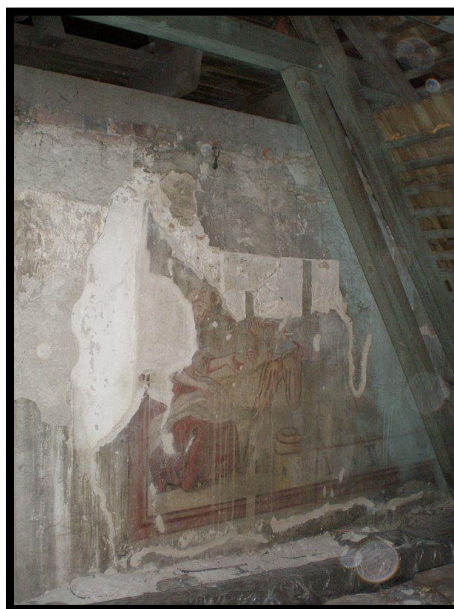
Obr. 24 Sluneční hodiny před rekonstrukcí zámku
