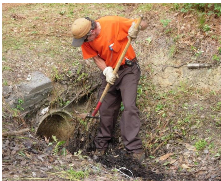
Obrázek 3: Příklad ručního čištění příkopů a propustků [4]
