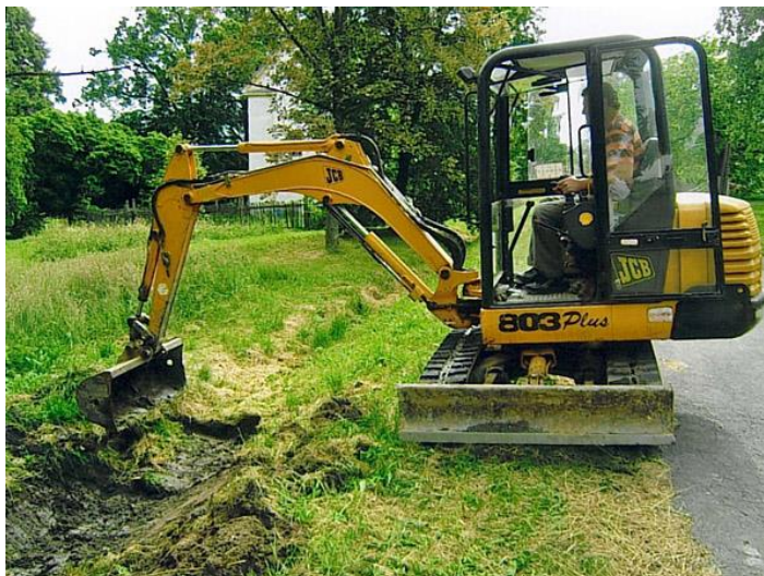
Obrázek 4: Příklad čištění příkopu za pomoci rypadlového bagru [5]
