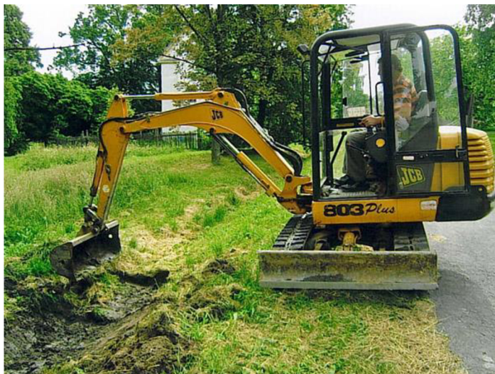
Obrázek 4: Příklad čištění příkopu za pomoci rypadlového bagru [5]
