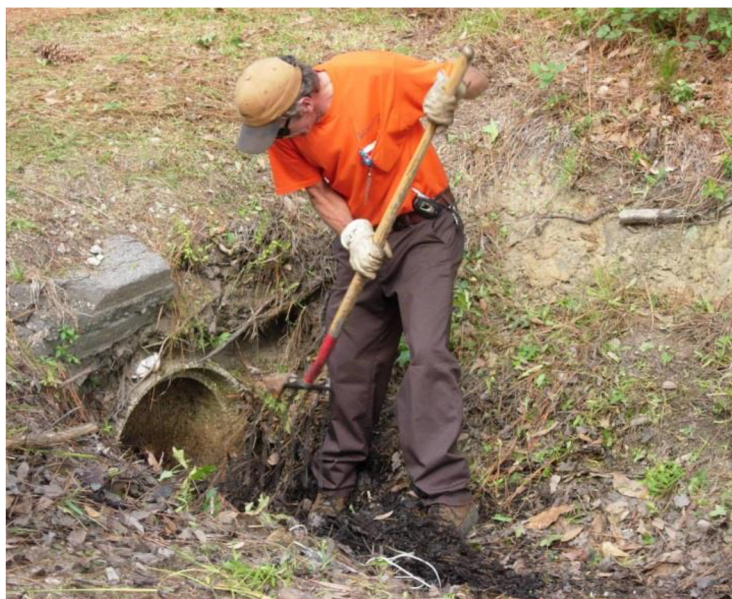
Obrázek 3: Příklad ručního čištění příkopů a propustků [4]
