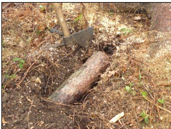
Obr. 15 Poleno uložené v mírném spádu, dalším krokem bylo zahrnutí polena zeminou
