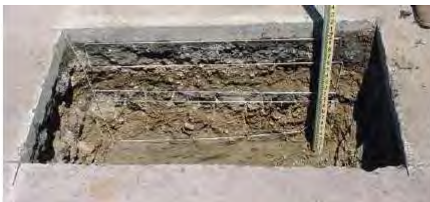
Obrázek 27 Příklad kopané sondy v konstrukci vozovky[49]
