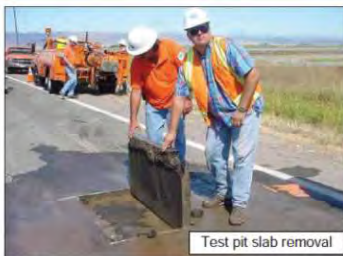
Obrázek 26 Výřez z konstrukce asfaltové vozovky [49]
