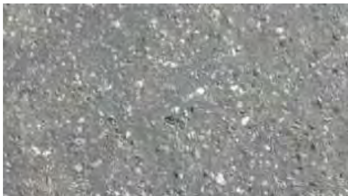
Obrázek 2 Příklad ztráty makrotextury [37]
