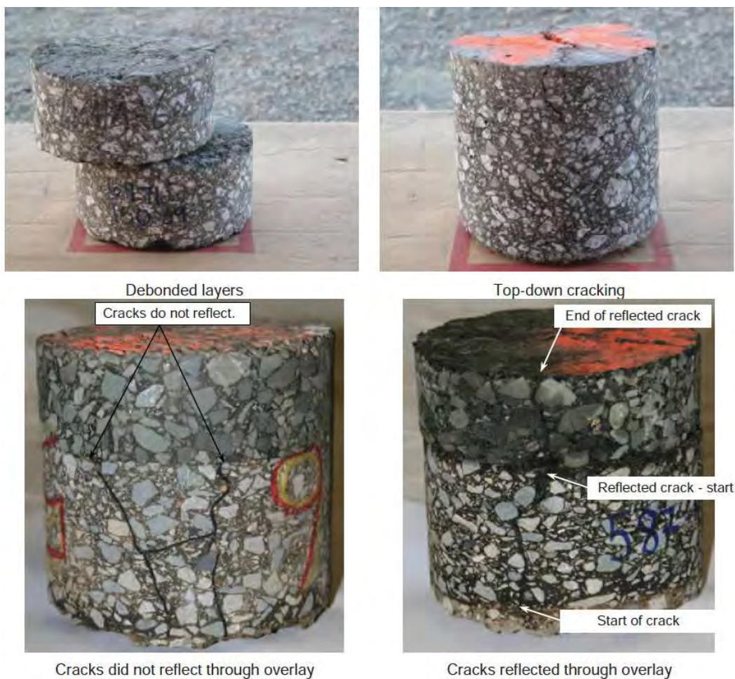
Obrázek 21 Příklady poruch zjištěných při vizuální kontrole na jádrových vývrtech [49]
