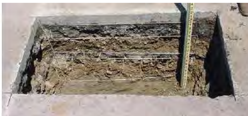
Obrázek 27 Příklad kopané sondy v konstrukci vozovky[49]
