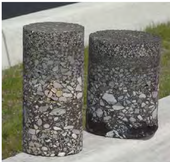
Obrázek 25 Jádřové vývrty z asfaltové vozovky [79]
