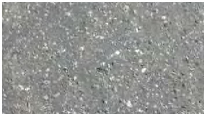
Obrázek 2 Příklad ztráty makrotextury [37]
