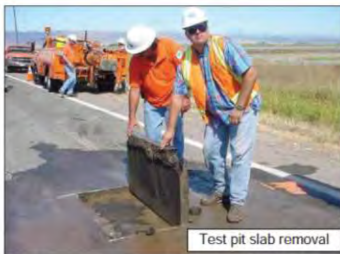
Obrázek 26 Výřez z konstrukce asfaltové vozovky [49]
