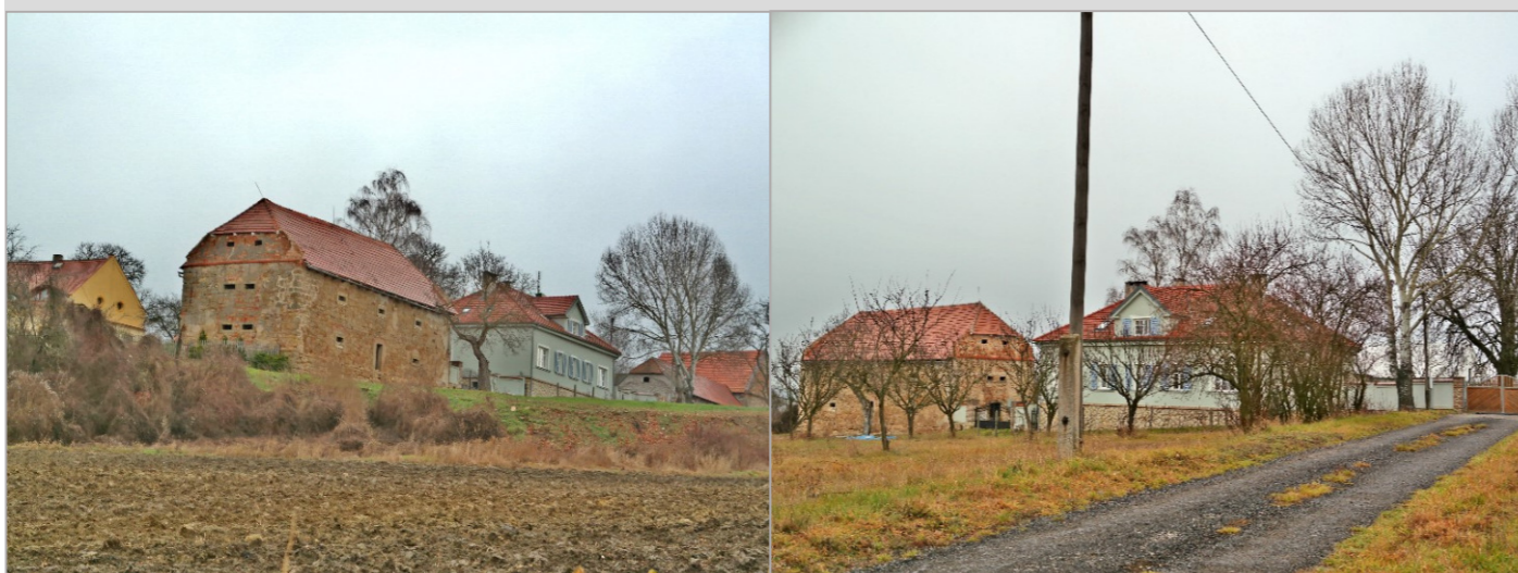
Pohled na dvůr Skašov
