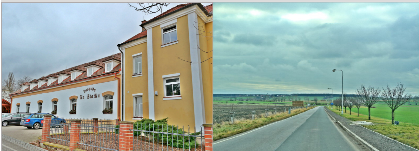
Bývalý hospodářský dvůr – jádro kompozice
