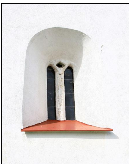
Obrázek 2 – Šikmá špaleta gotického okna (Hauner, 2008)
