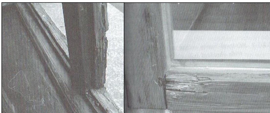
Obrázek 15 - Příklad poškození dřeva vodou, zleva: poškození okenního rámu, poškození okenního křídla (Ptáček, 2009)
