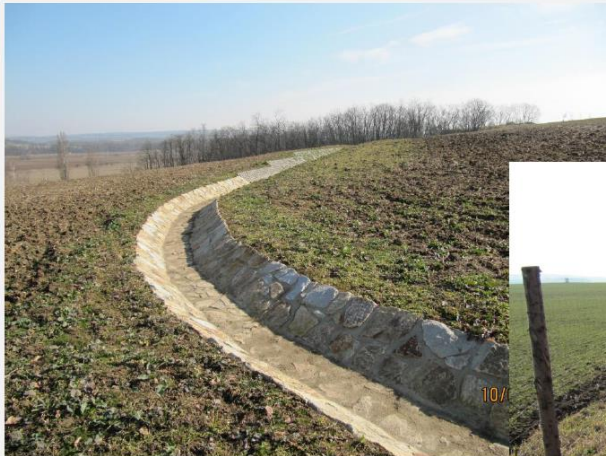
protierozní příkop otevřený
