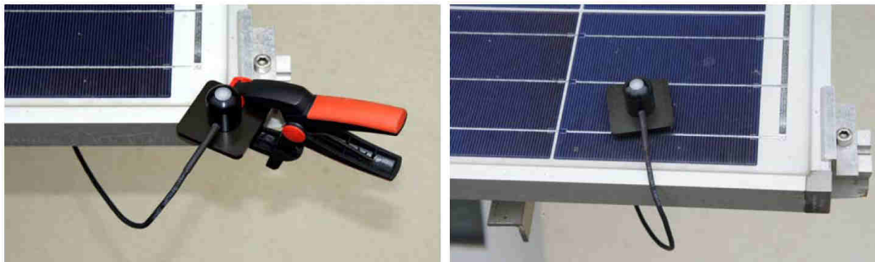
Obr. 4.3-1 Příklad správného a chybného umístění snímače ozáření [35]
