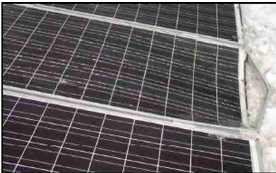
Obr. 2.3-3 Promáčknutý FV panel a ohnutý rám [18]
