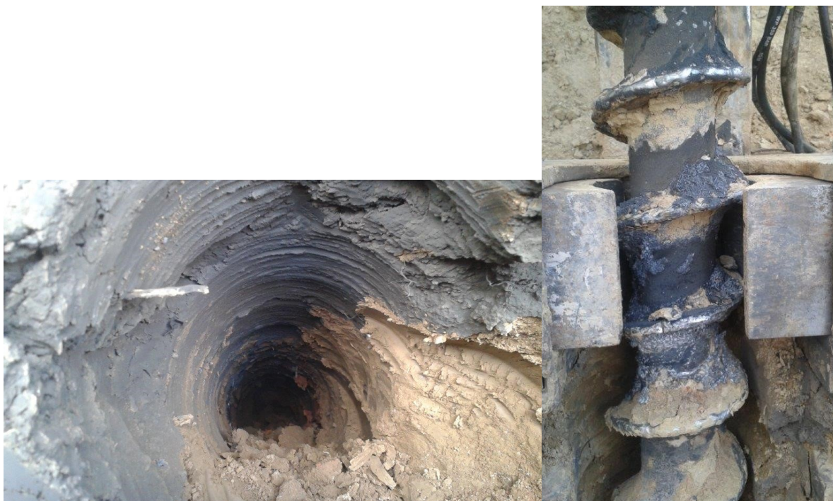
Obr. 5-8 Porucha č.3: místo poruchy VN 219, vrtací souprava
