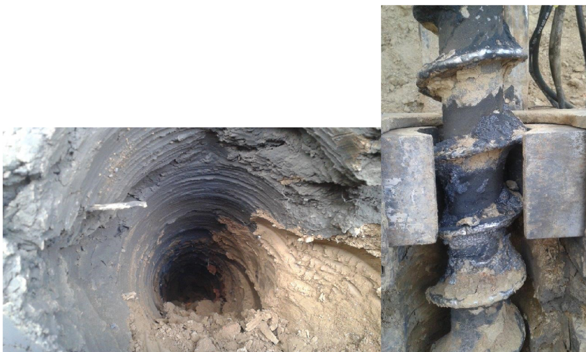
Obr. 5-8 Porucha č.3: místo poruchy VN 219, vrtací souprava
