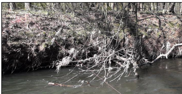
Obr. 53 Podemletí pravého břehu profilu č. 13
