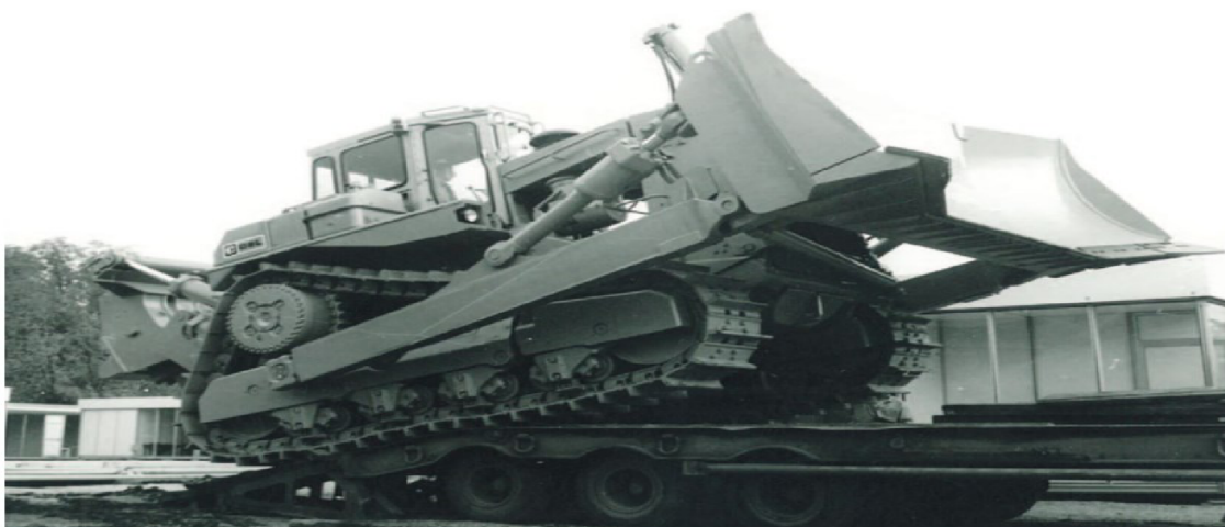
Obr. 2.7 Stavební stroj Caterpillar 1969
