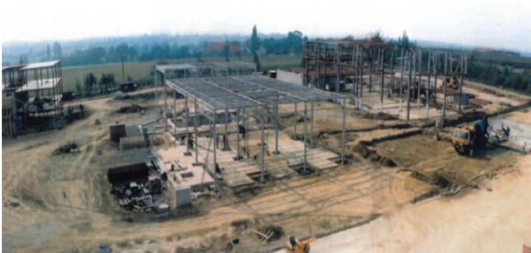
Obr. 2.8 Phoenix-Zeppelin na D1 1995 (výstavba areálu v Modleticích)
