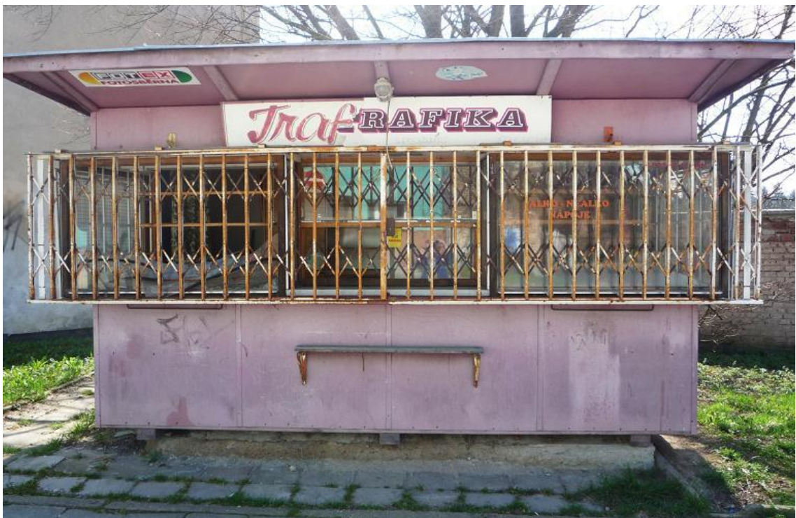
Obr. 12: Chátrající objekt bývalé trafiky (zdroj: vlastní fotodokumentace)
