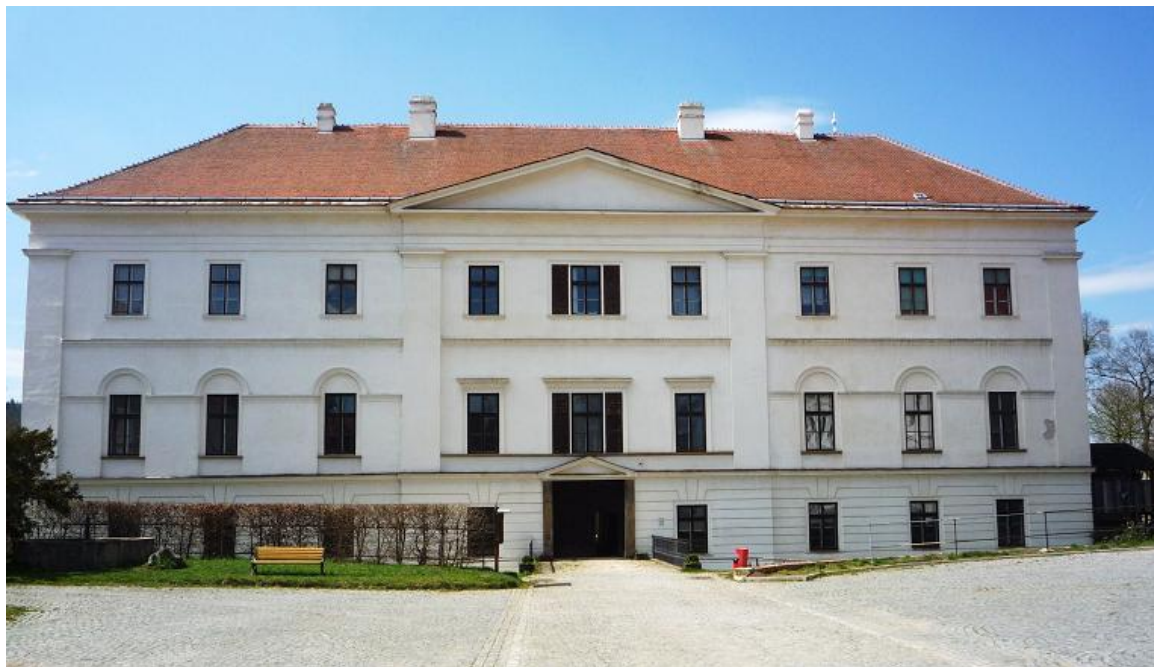
Obr. 3a: Zámek v Rosicích (zdroj: vlastní fotodokumentace)
