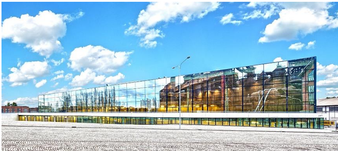
Obr. 32 Velký svět techniky, STC - DOV (zdroj: www.ostrava.cz )
