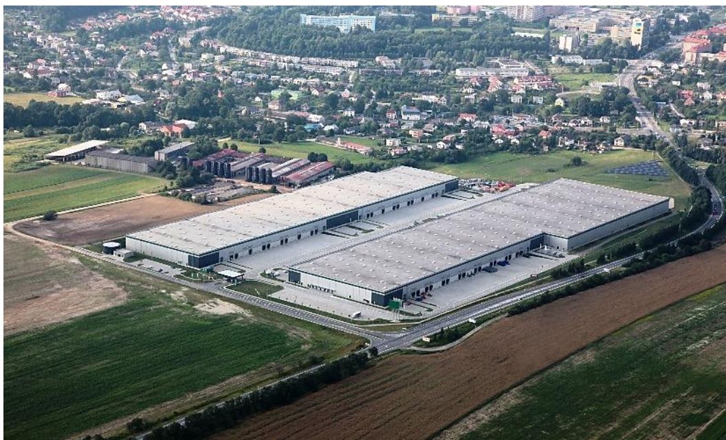
Obr. 26 ProLogis, logistický park Ostrava-Poruba (zdroj: www.ostrava.cz )
