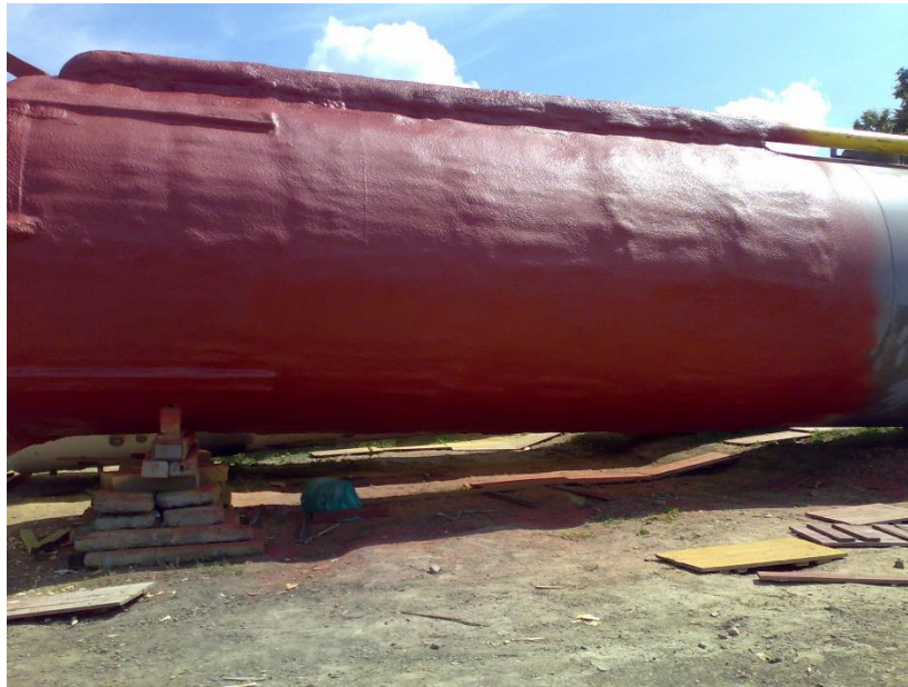
Obr. 26 Ocelová nádrž s polyurea nástříkem [28]
