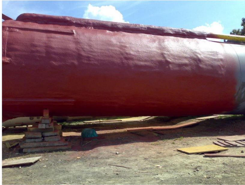
Obr. 26 Ocelová nádrž s polyurea nástříkem [28]
