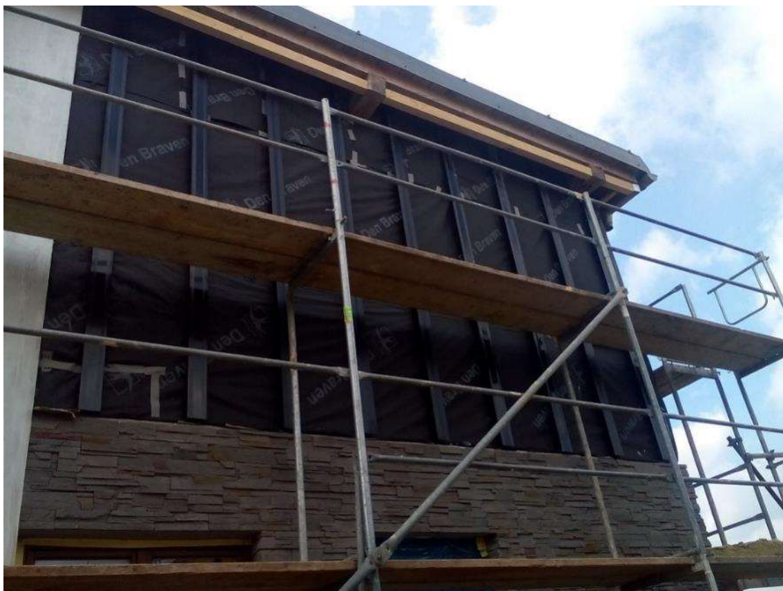
Obrázek 4 Montáž nosného roštu, Zdroj (14)
