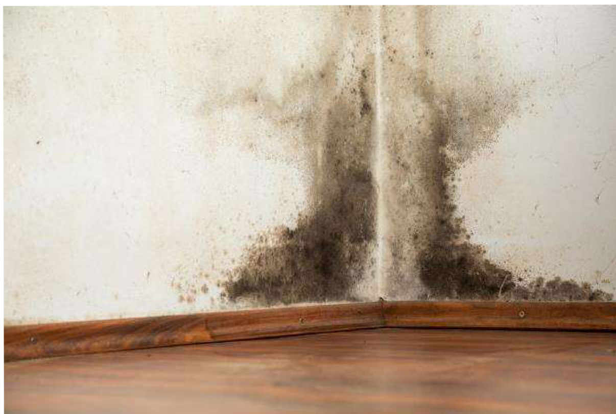
Obrázek 6 Plíseň způsobená špatným zateplením KZS, Zdroj (12)
