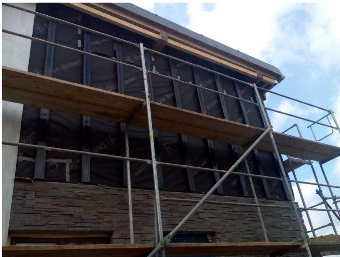
Obrázek 4 Montáž nosného roštu, Zdroj (14)
