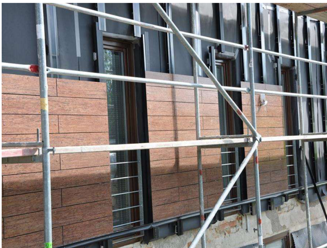
Obrázek 4 Montáž nosného roštu, Zdroj (14)
