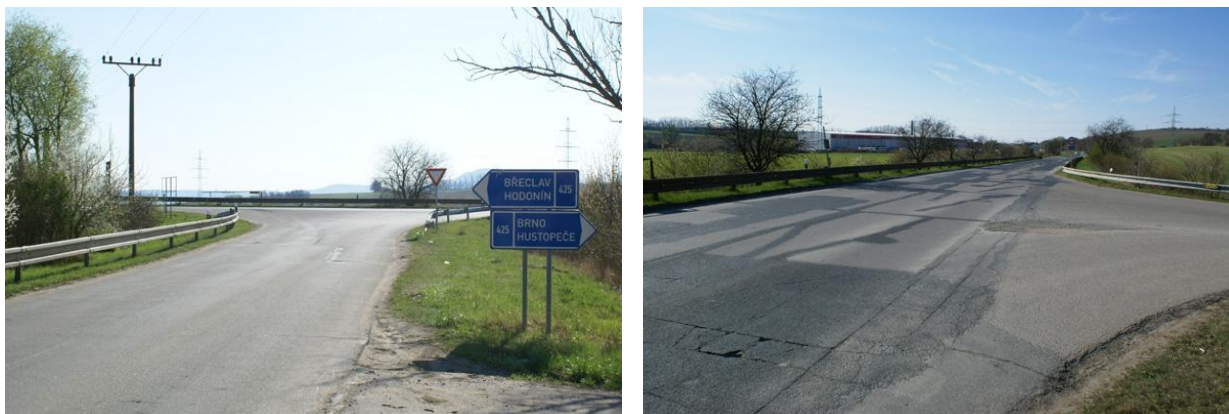
Obrázek 5: Křižovatka z pohledu příjezdu po vedlejší PK a z pohledu směrem k obci Hustopeče [39]
