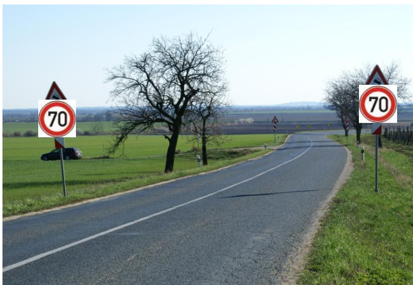
Obrázek 12: Fotomontáž navrhované úpravy snížení rychlosti [39]
