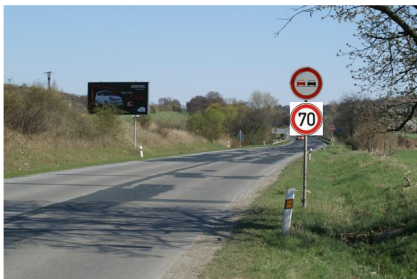
Obrázek 7: Fotomontáž navrhované úpravy snížení rychlosti na hlavní silnici [39]
