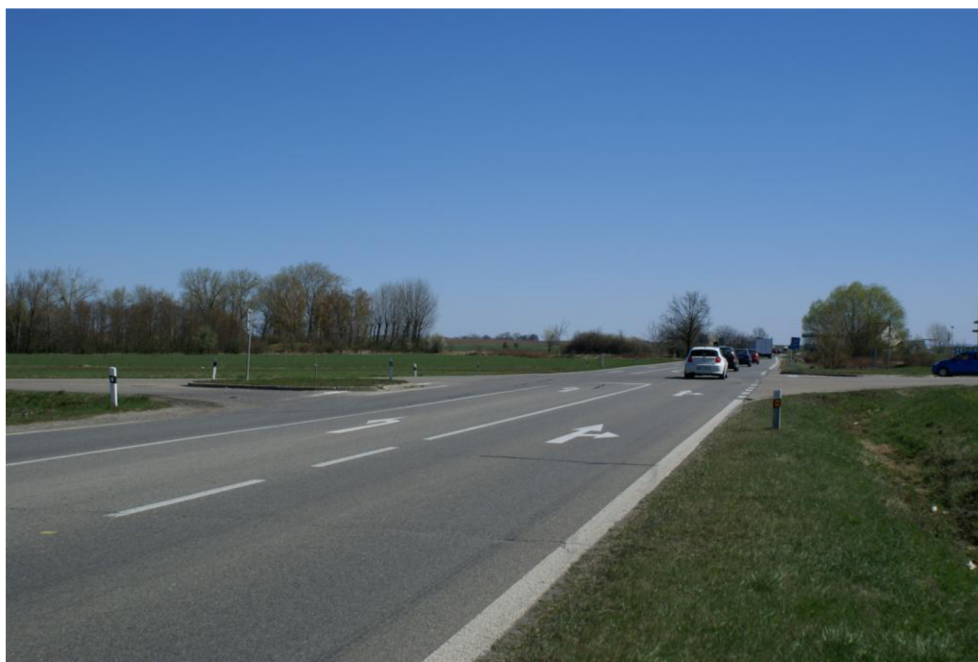
Obrázek 30: Pohled na křižovatku silnic I/55 a II/422 – hlavní pozemní komunikace [39]
