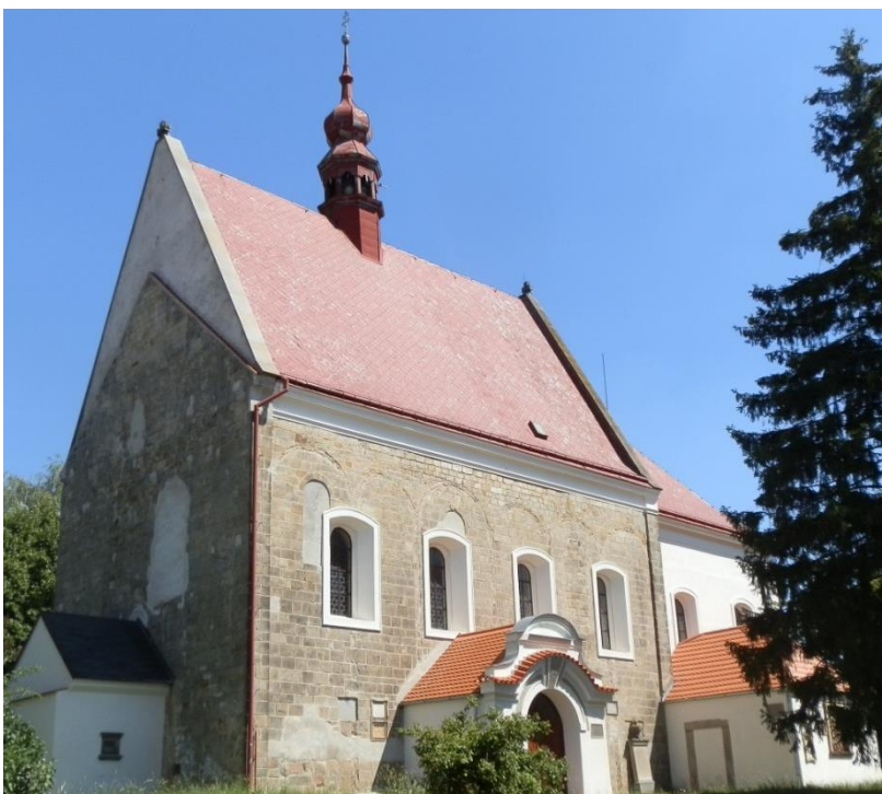
Obr. č. 3 – Kostel Nanebevzetí Panny Marie v Libčanech (okr. Hradec Králové) od jihozápadu. Kolem roku 1225. Foto archiv autora.
