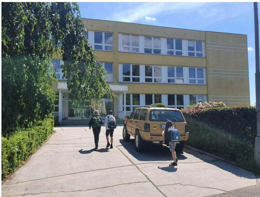
Obrázek 1: ZŠ Mozartova, pohled na vchod budovy
