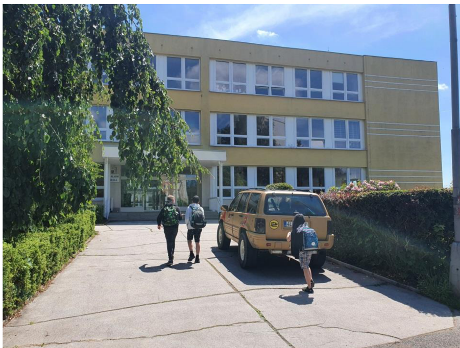
Obrázek 1: ZŠ Mozartova, pohled na vchod budovy
