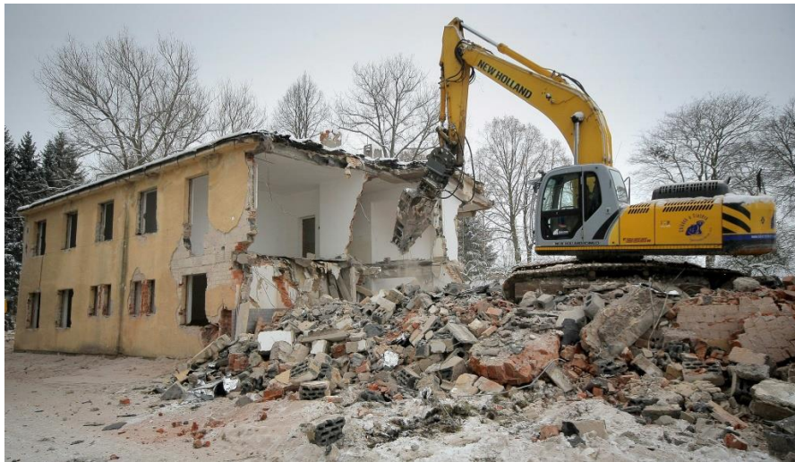
Obr. 3.5 Bagr s hydraulickými kleštěmi [6]
