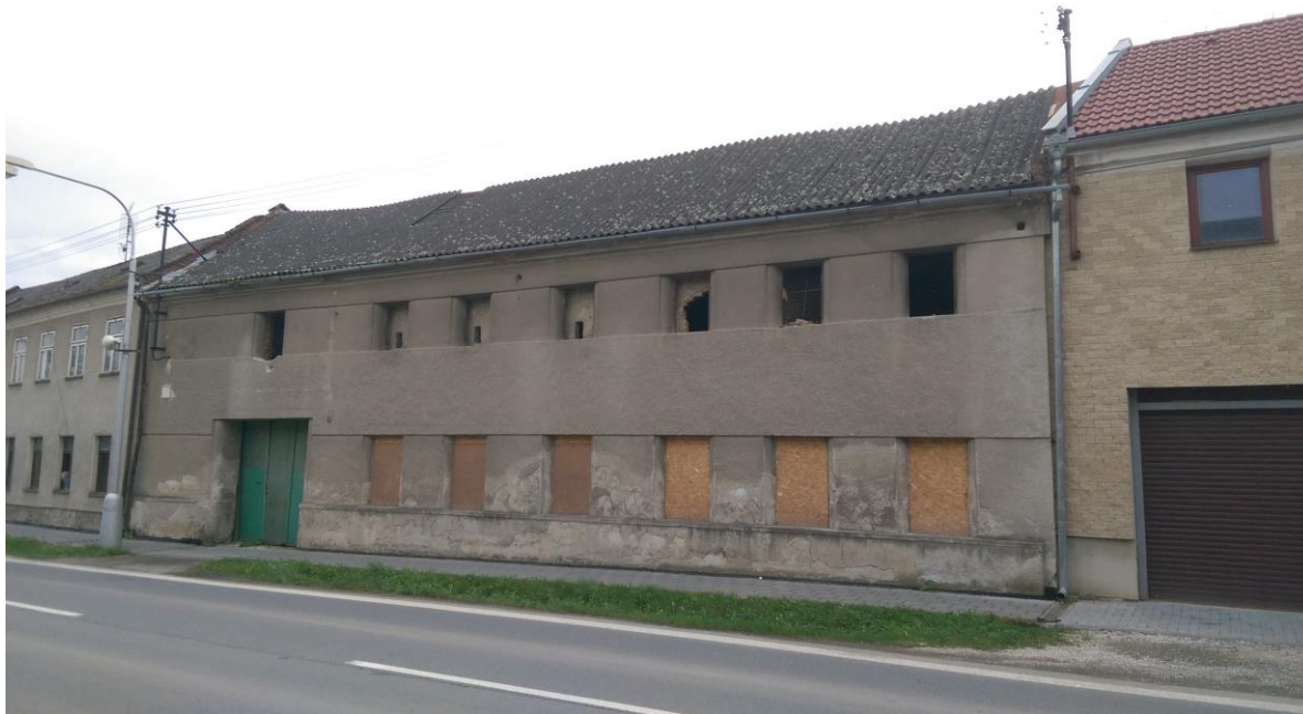
Obr. 4.6 Pohled z ulice
