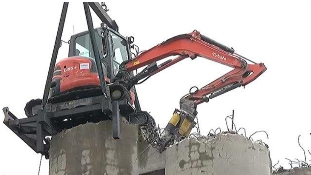
Obr. 3.7 Bourání komínu bagrem zavěšeným na jeřábu [8]
