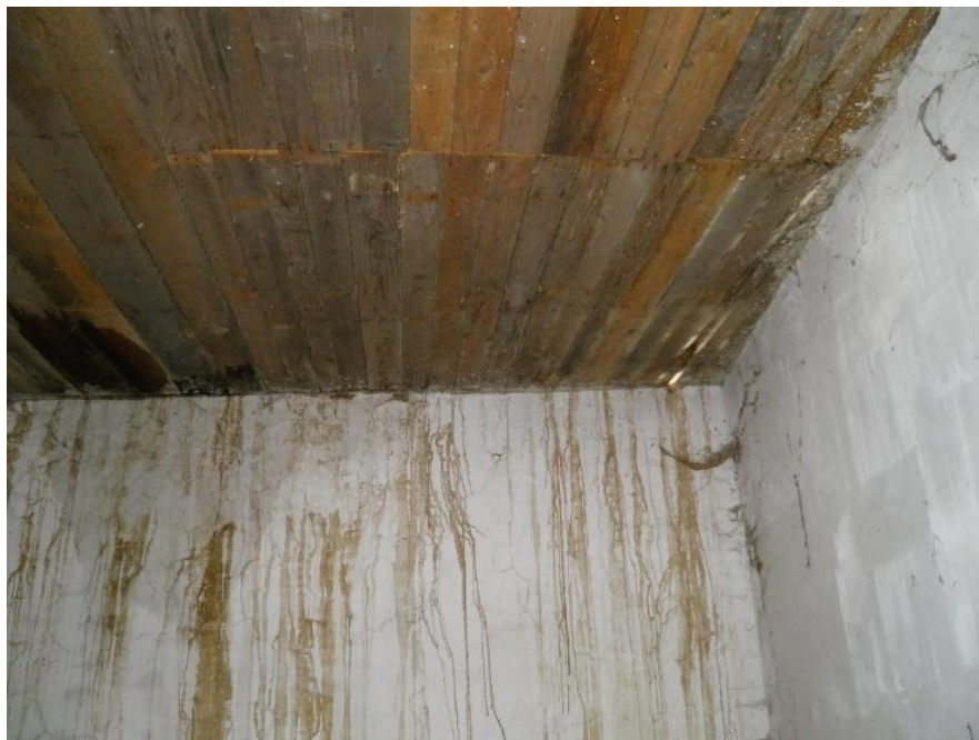
Obr. 4.10 Zatékání
