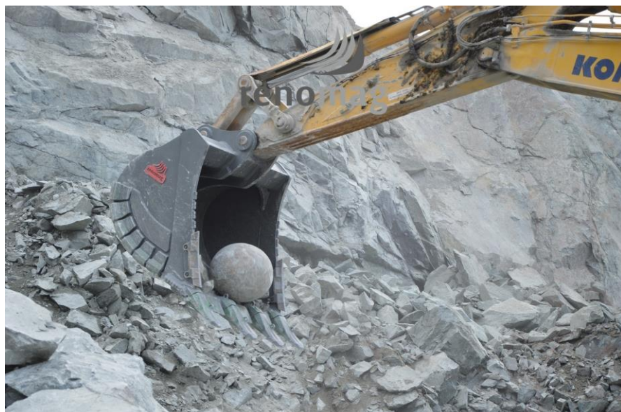
Obr. 3.6 Vypouštění demoliční koule [7]
