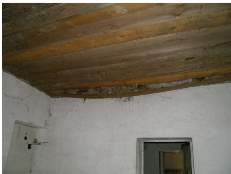
Obr. 4.16 Poškození stropu
