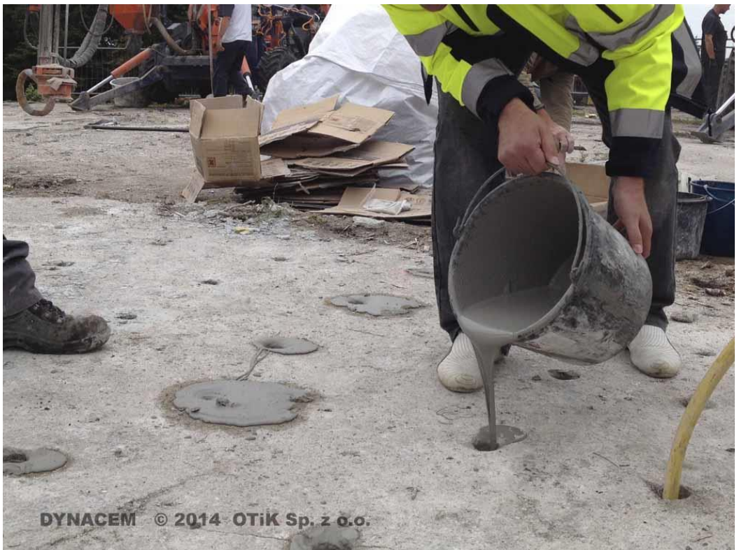
Obr. 3.12 Aplikace nevýbušné trhavinny do vyvrtaných děr [13]
