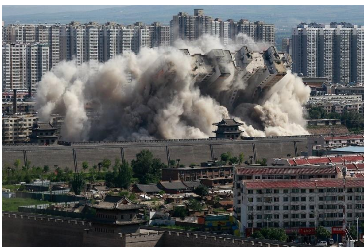
Obr. 3.9 Bourání odstřelem [10]
