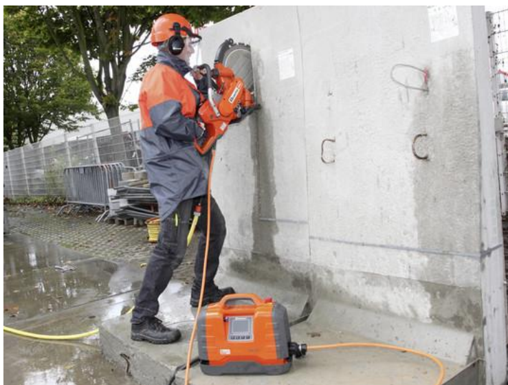
Obr. 3.8 Řezání kotoučovou pilou za současného přívodu vody [9]
