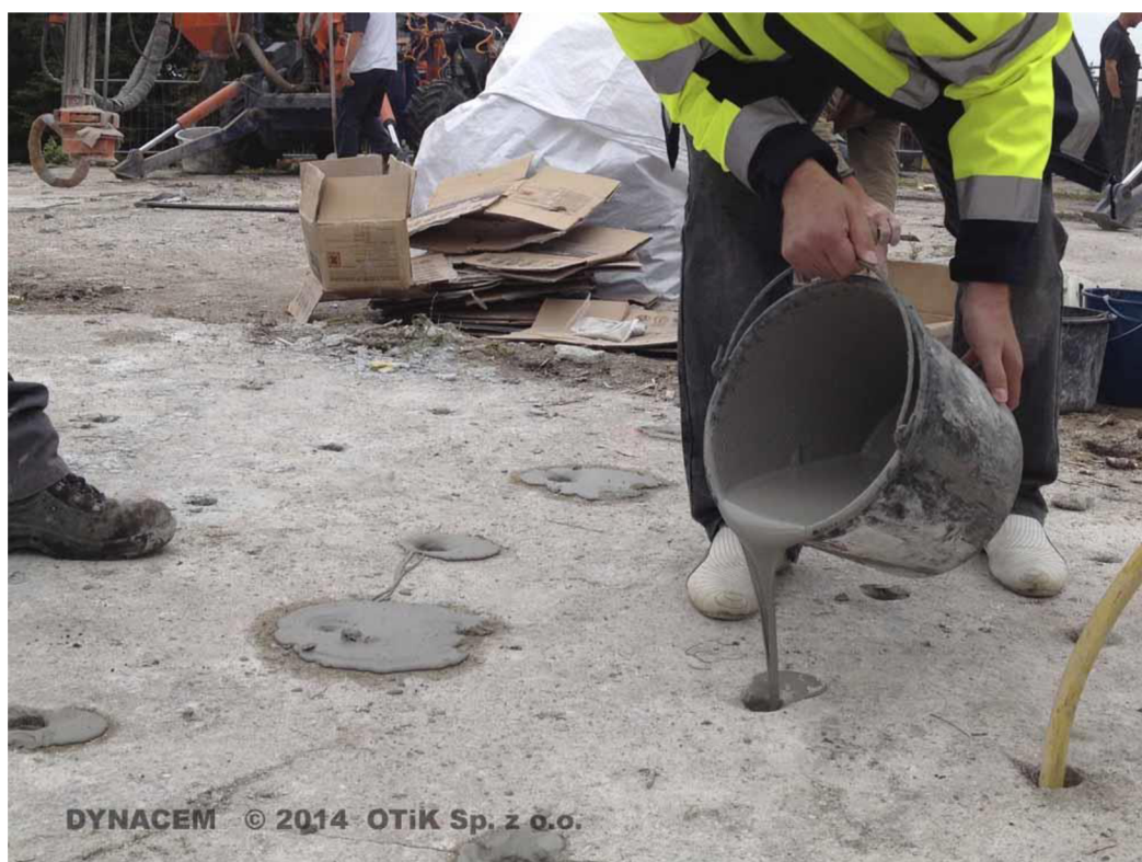
Obr. 3.12 Aplikace nevýbušné trhavinny do vyvrtaných děr [13]
