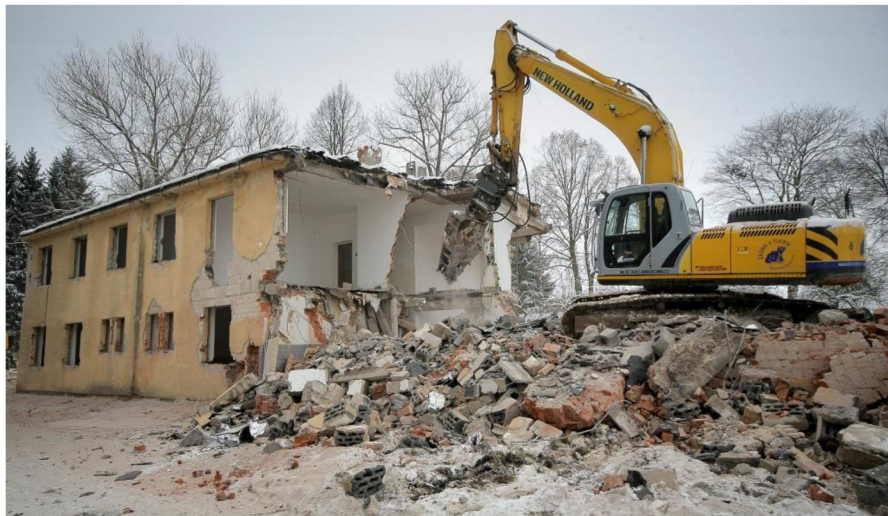
Obr. 3.5 Bagr s hydraulickými kleštěmi [6]
