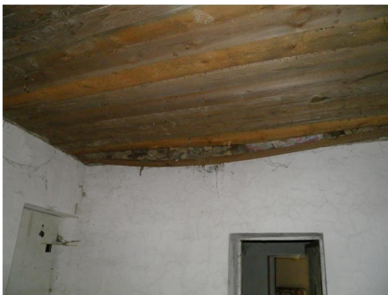
Obr. 4.16 Poškození stropu
