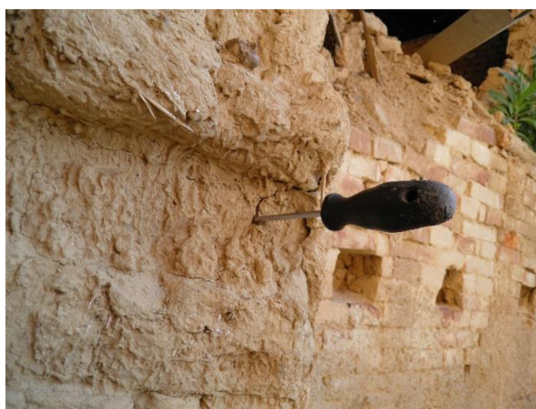
Obr. 4.12 Vrypová zkouška na nepálené cihle
