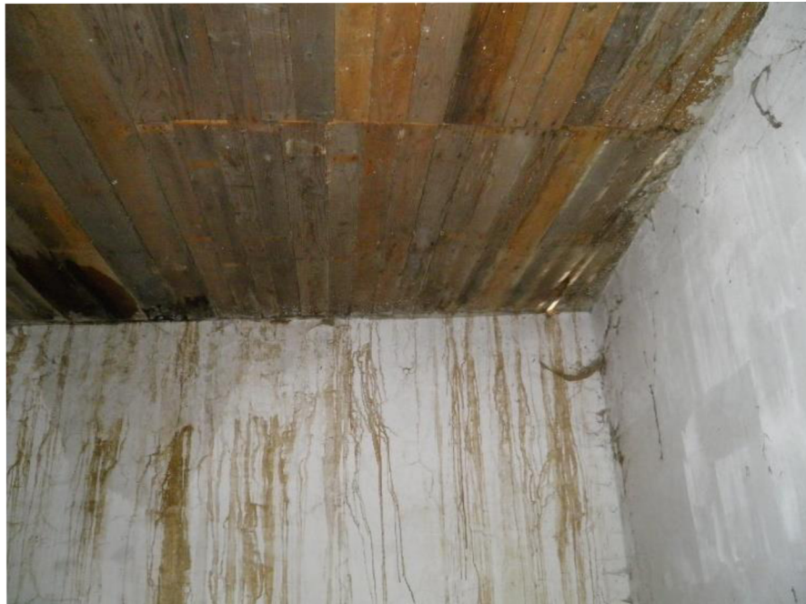
Obr. 4.10 Zatékání
