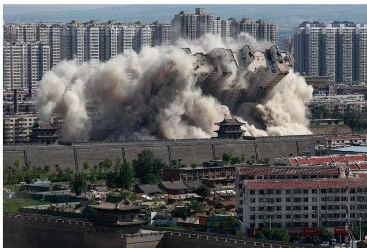
Obr. 3.9 Bourání odstřelem [10]
