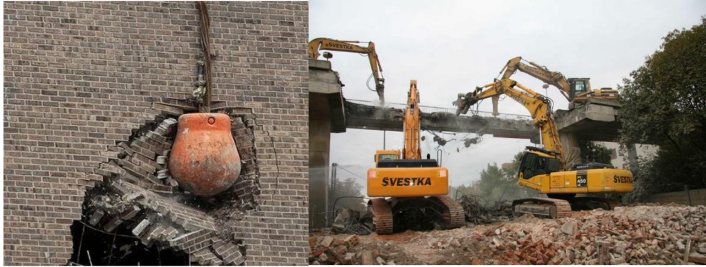
Obr. 3.3 Zavěšená bourací koule [4]
