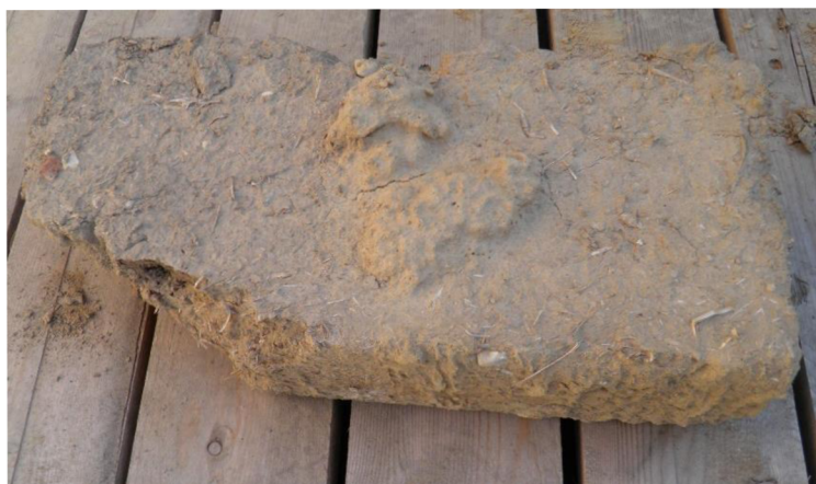
Obr. 4.8 Detail uvolněné nepálené cihly (vepřovice)
