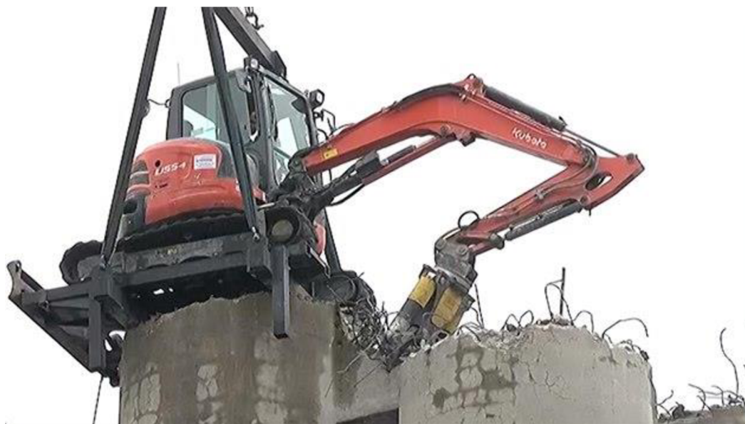
Obr. 3.7 Bourání komínu bagrem zavěšeným na jeřábu [8]
