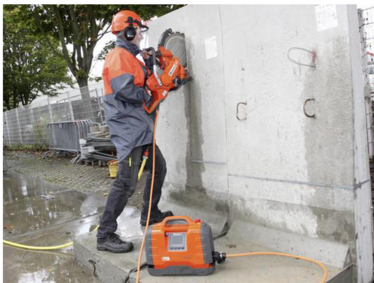
Obr. 3.8 Řezání kotoučovou pilou za současného přívodu vody [9]
