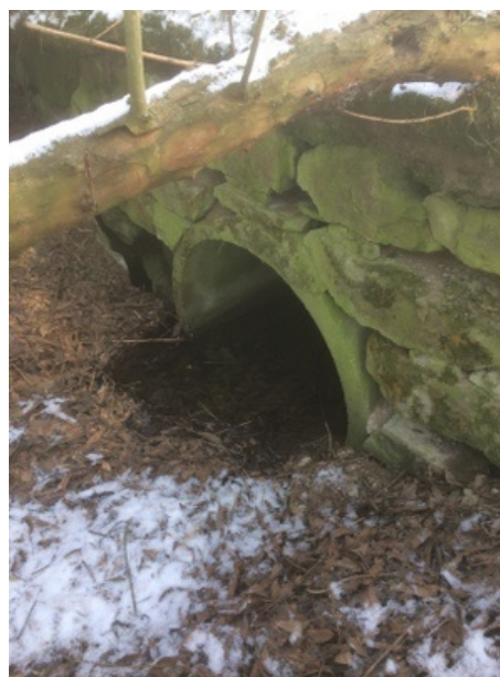
Obrázek 67- Stávající propust P12 - výtok
