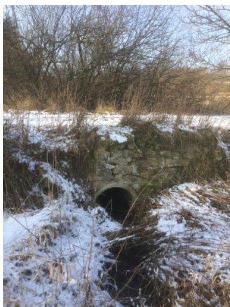
Obrázek 66- Stávající propust P12
