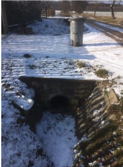
Obrázek 34- propustek P10 u stavení
