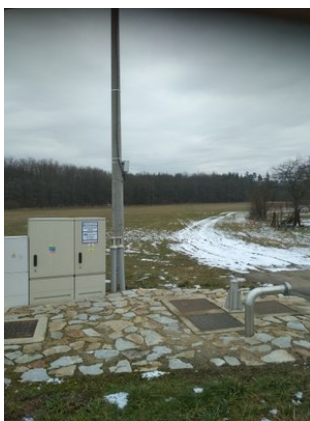
Obrázek 58- Zpevněný sjezd a vedení trasy DC5
