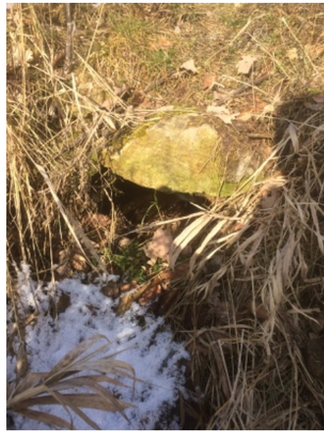
Obrázek 71- Stávající propustek P14
