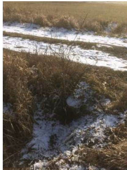
Obrázek 69- Stávající propustek P13
