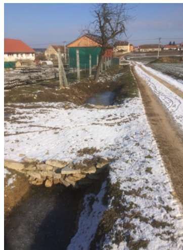
Obrázek 31 - přejezd přes propustek P3
