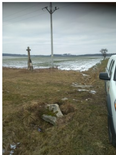
Obrázek 73 - Stávající propustek P18
