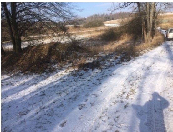
Obrázek 57- Vedení DC4-R přes propustek P12
