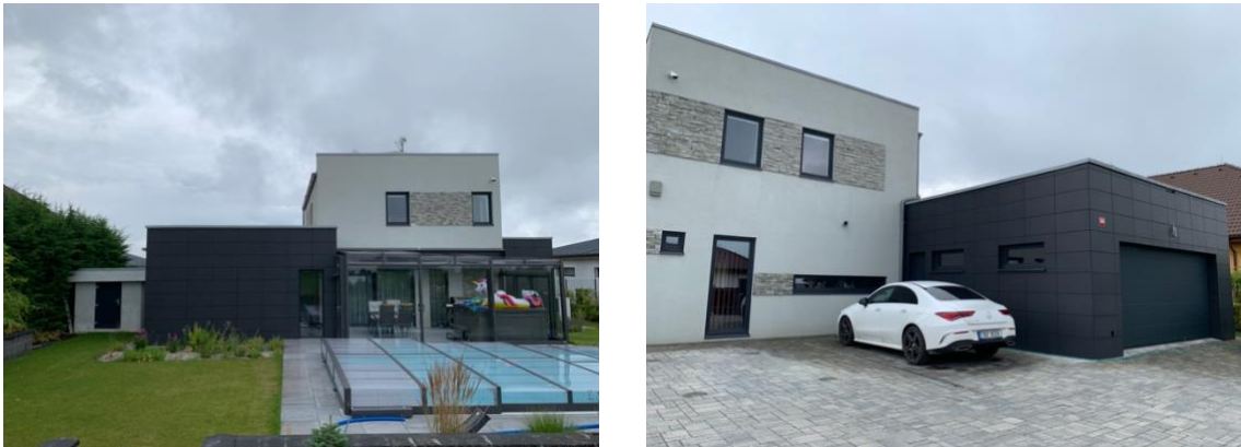
Obr. 12 – Fotografie dotčeného RD, zdroj: vlastní
