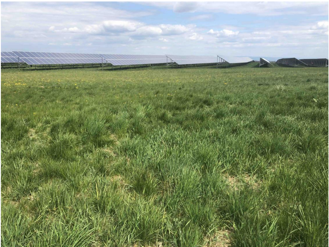
Příloha 2 Fotovoltaická elektrárna Ochoz
