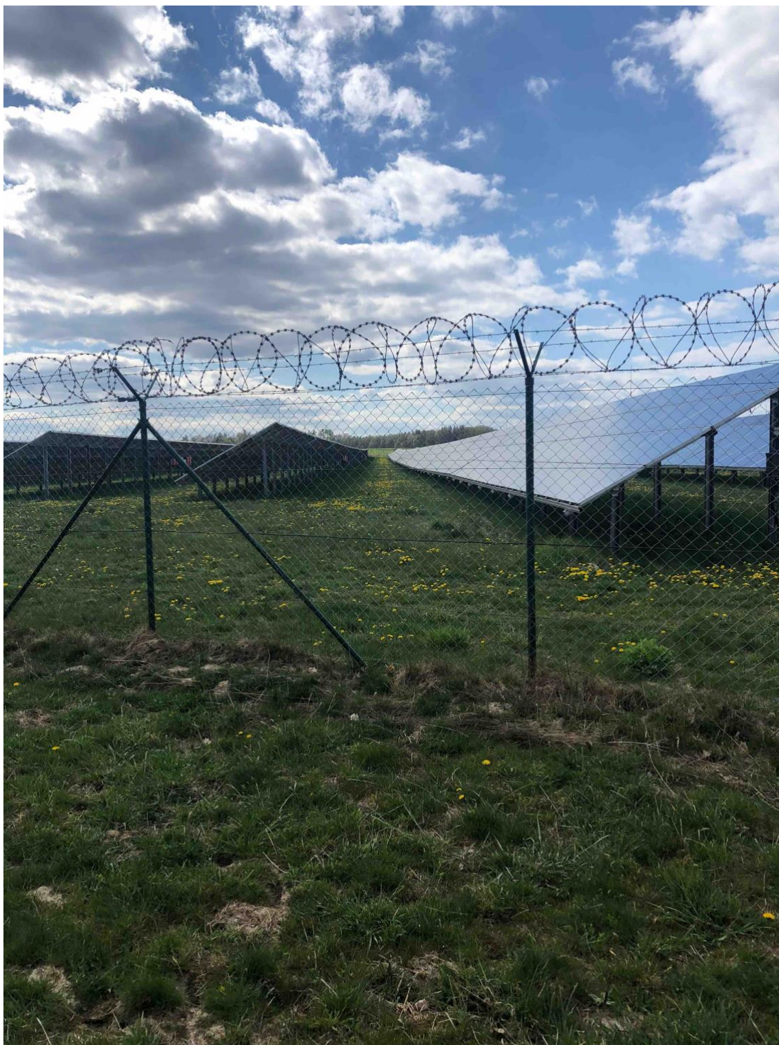
Příloha 5 Oplocení fotovoltaické elektrárny Raková u Konice
