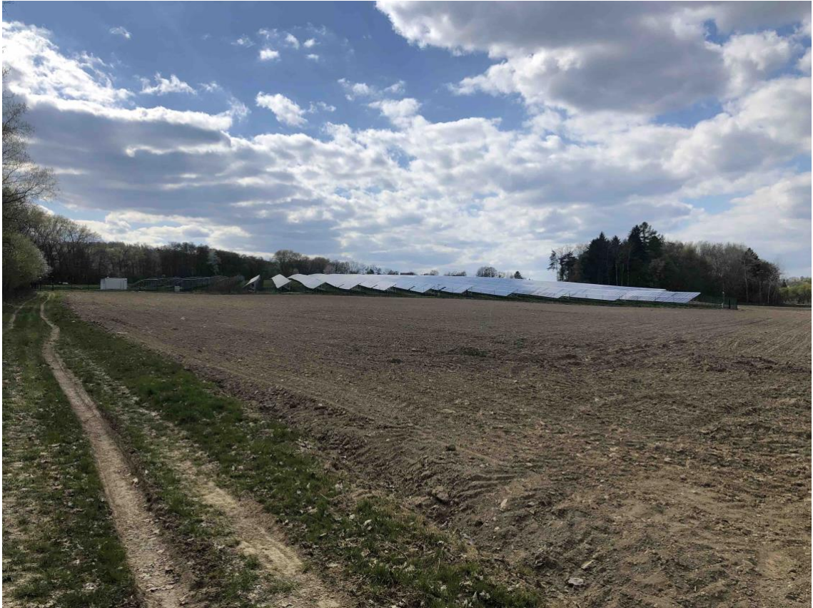
Příloha 3 Fotovoltaická elektrárna Jesenec
