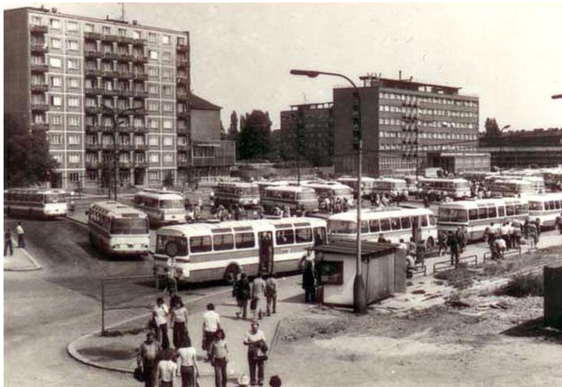
Obrázek P17: Pohled na dostavěné autobusové nádraží (1969), později několikrát upravováno. Zdroj: fotografie: Tomáš Ertl https://i.pinimg.com/originals/ed/78/b9/ed78b95b2c78e2beb9252f37fc4f2822.jpg
