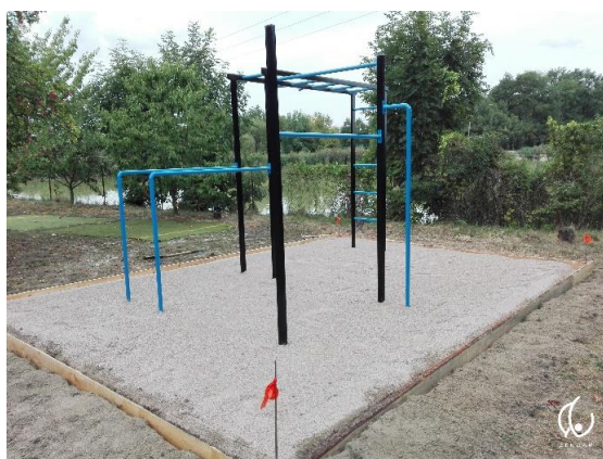
Obr. 65 Workoutové hřiště – rovnání půdy, příprava pevné plochy
