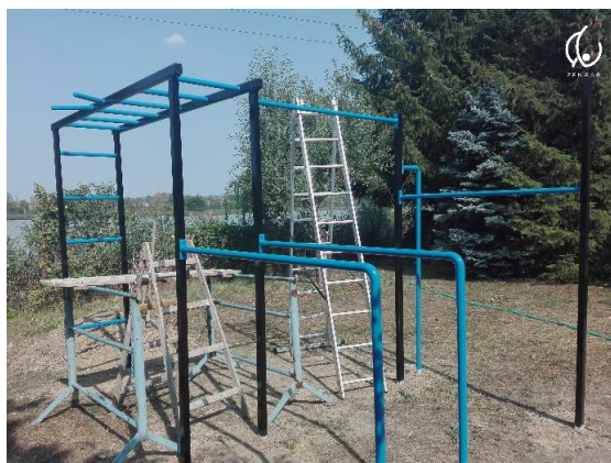
Obr. 64 Workoutové hřiště – kotvení a betonování 2
