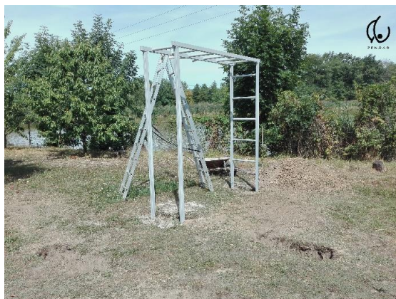
Obr. 63 Workoutové hřiště – kotvení a betonování zdroj: vlastní
